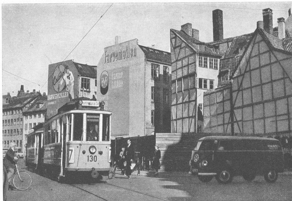
De færdselslinier, der tidligere er gennemført i forbindelse med saneringer, er i flere tilfælde ikke afsluttet med en ordning af bebyggelsen. Ny Østergade-gennembruddet er fra 1907.
