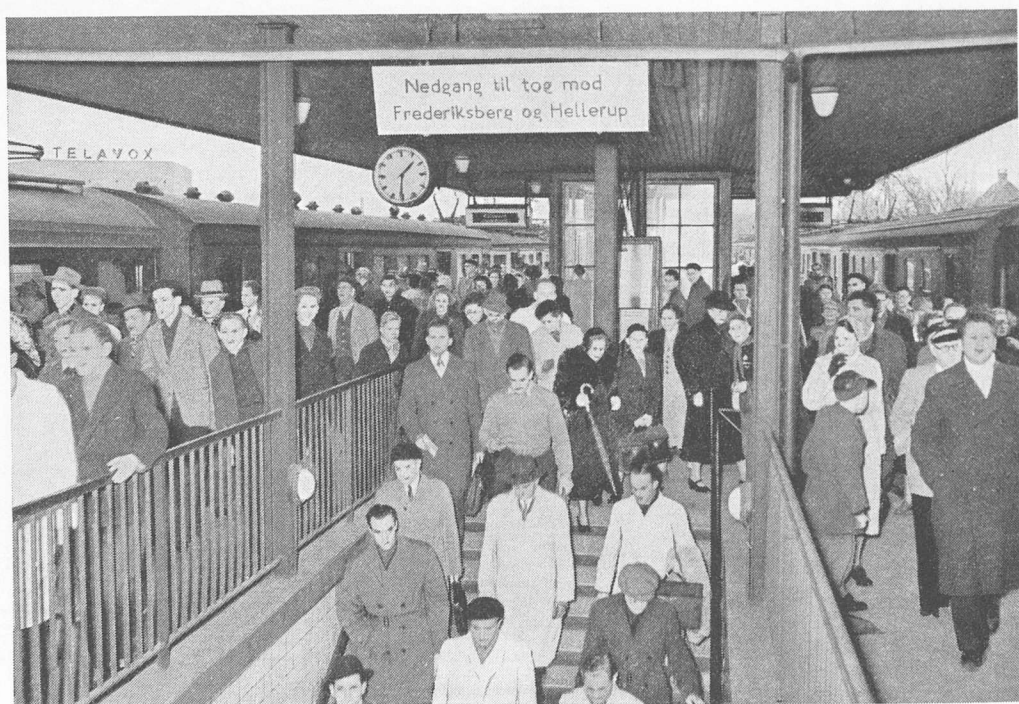
Ved indføringen af elektriske baner fra omegnen til bymidten overvindes afstandene i den voksende storby, samtidig med at byens gader befries for en del af trafikken.
