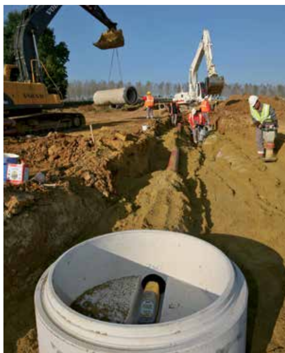
Fonds hydrauliques Stradifond DN1000 prêts-à-poser.
