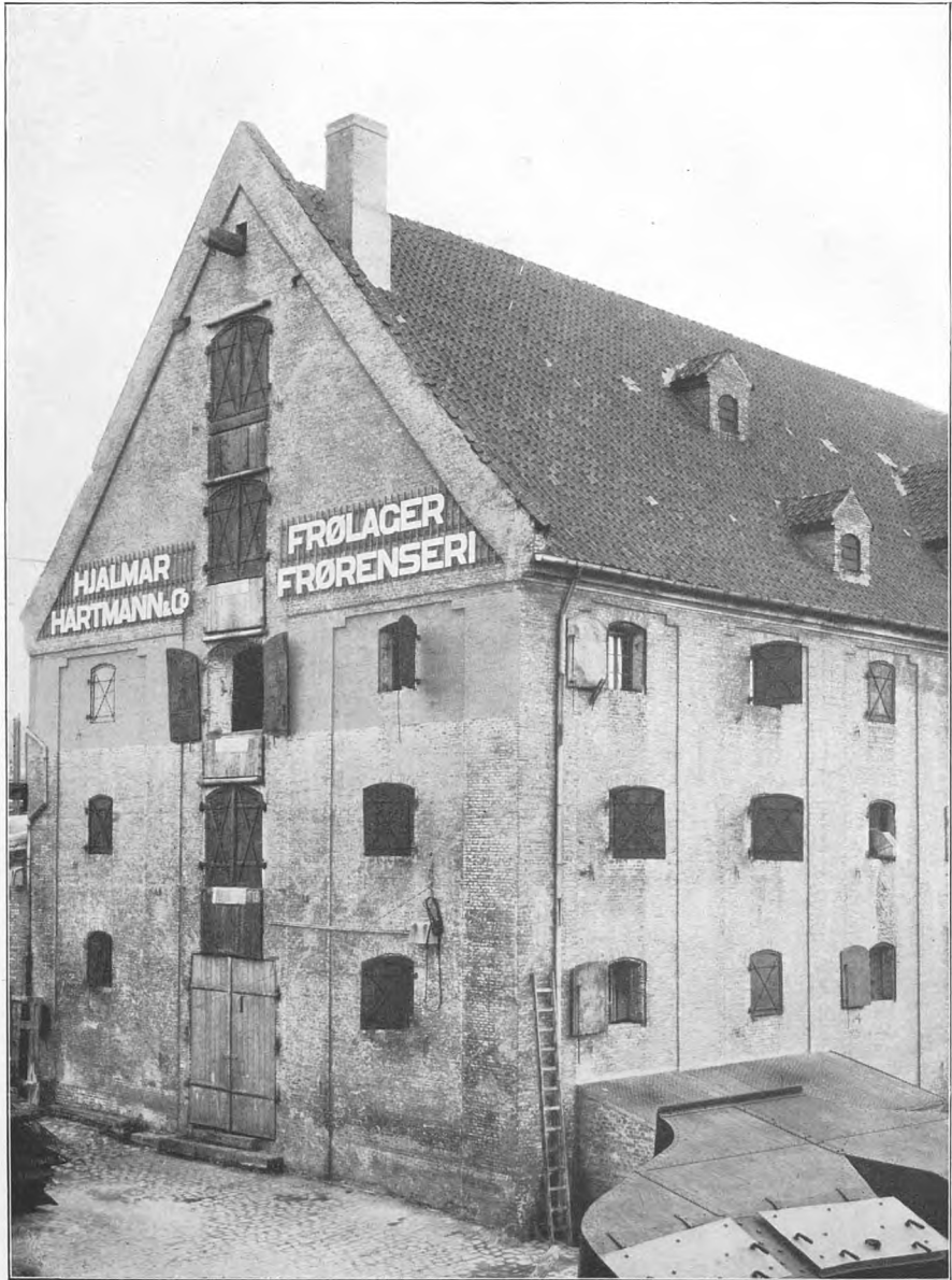
LAGERBYGNING WILDERS PLADS
