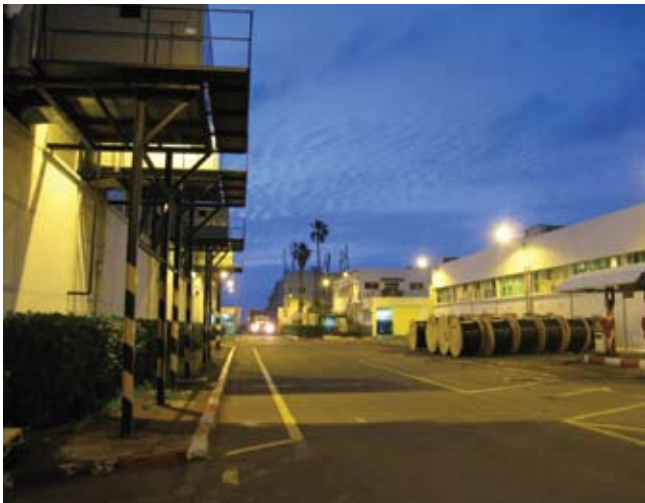
▲ Kabelherstellungsanlage von Nexans in Marokko
