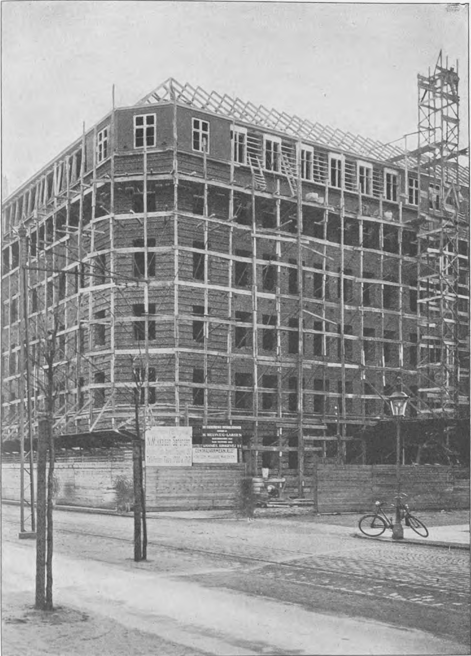
Bygning med Stillads og Elevator-tårn.
