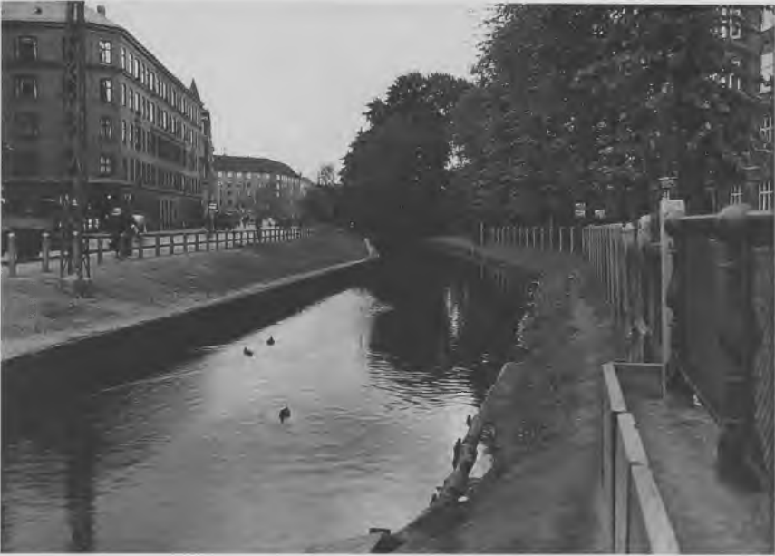
Ladegårdsåen eller »havet«, som Alex Fischer kalder det, set fra Jagtvej ind langs Ågade 1940. Åløbet blev lagt i rør og overdækket efter 1950. Stadsingeniørens direktorat.
