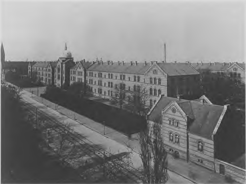
Kommunehospitalet opført 1863 med hovedfacade til Øster Farimagsgade. Til venstre for kirkefløjen lå kvindeafdelingen, til højre mandsafdelingen. De to villaer tjente som embedsboliger den første tid for overkirurgen og hospitalsforstanderen. Foto ca. 1900. Københavns Bymuseum.
