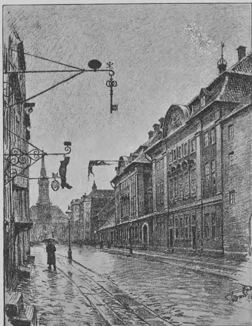
Ostindisk Kompagnis Bygninger i Strandgade.
