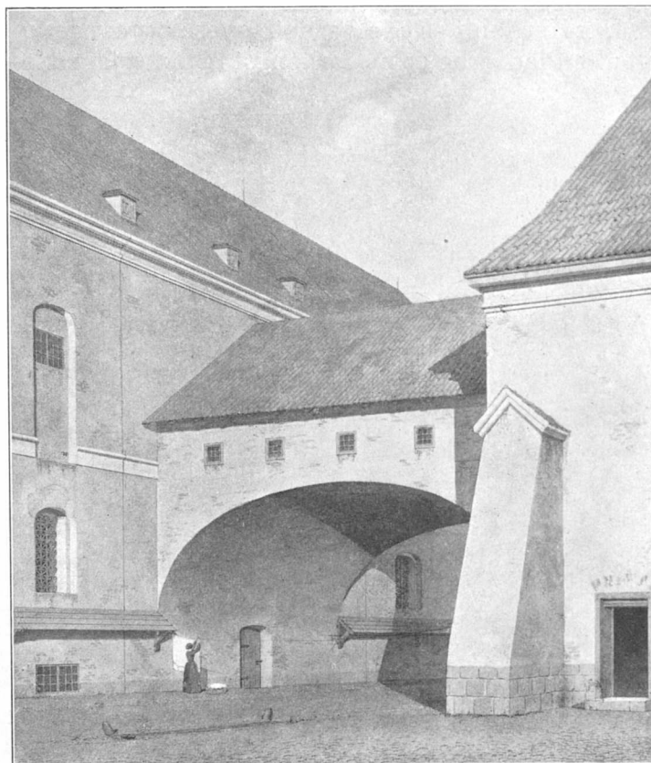
Hans J. Holm, 1856: Proviantgaardens sydøstlige Hjørne med Løngangen mellem Provianthuset og Bageribygningen (Galejhuset).
