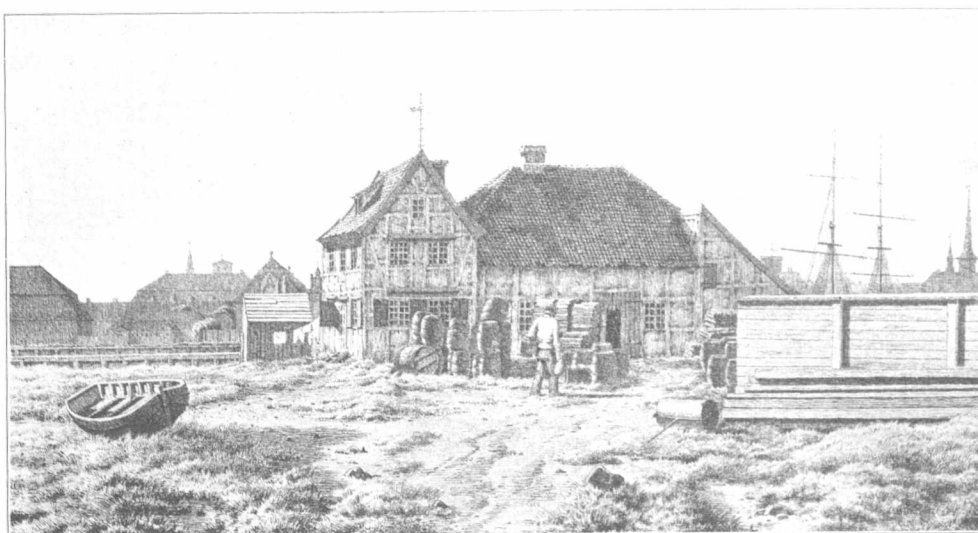
P.Ølsted, ca. 1867: Skibsbyggermesterens Hus paa Holms Plads, set mod Slotsholmen.
