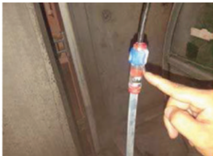
▲ Рисунок 5: Замороженная вода у концевых заглушек
