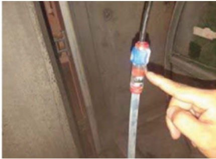
▲ Figura 5: Agua congelada alrededor de las tapas terminales
