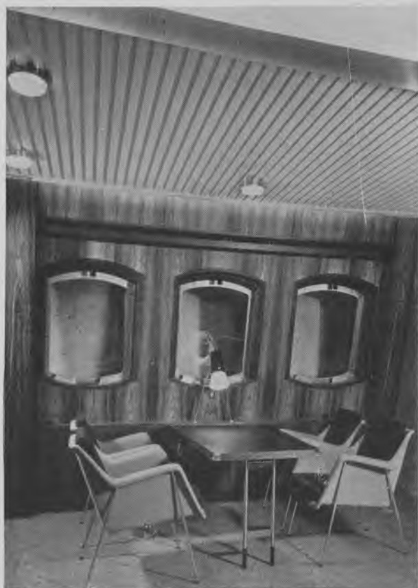
Fig. 1517. To billeder af salonmodellen til M/S »PRINSESSE MARGRETHE« visende en opholdsgruppe. Forneden detaille af bordhjørne og understøtning, den sidste udført af rustfrit stål med parkeriserede sokler.
