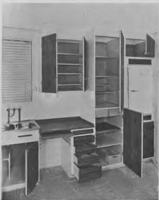
Fig. 1280. Køkken fra »Bygge- og Boligudstillingen« på Bellahøj 1953. Bordplade, udtræk, skuffeforstykker og dørflader er i teak. (Bemærk det brede forrammestykke mod loftet, bag dette er der plads til eventuelle rørinstallationer.) Arbejdslys til bordpladen er anbragt under vægskabets bund.
