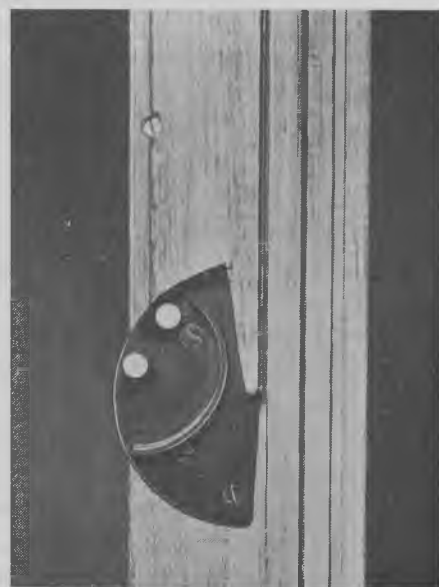
Fig. 1060. Pivothængsel i ramme.
