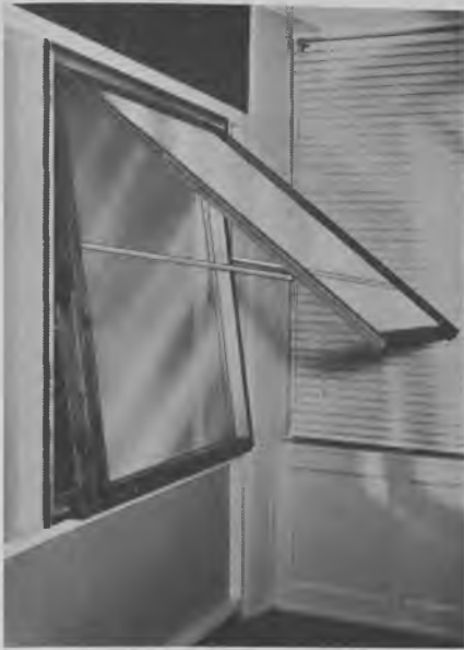
Fig. 1061. Rammen i pudsestilling.
