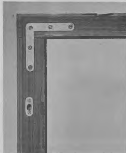
Fig. 1064. Slutblik til koblingsbeslag og hjørnebånd.
