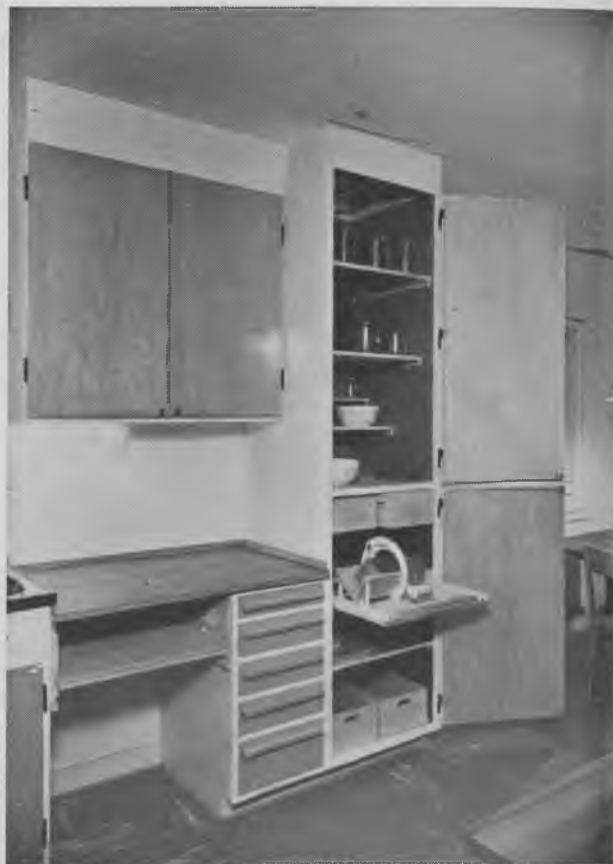
Fig. 1282. Spisekammer med brødsuffe og udtræksbakke til brødmaskine samt to skuffer i bunden af skabet til grøntsager eller flasker.
