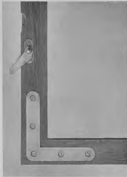
Fig. 1063. Koblingsbeslag med fingergreb og hjørnebånd.
