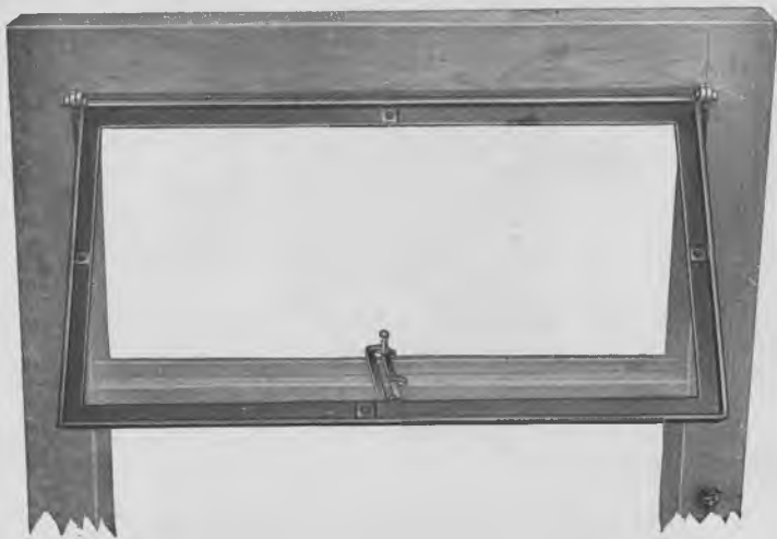
Fig. 1017. Ventilationsramme beslæet i vinduesramme med pinolhængsel og udskyderstang. (Peder Nielsen.)
