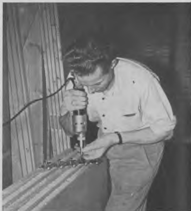
Fig. 1128. Påskrining af beslag på maskinslåede døre.
