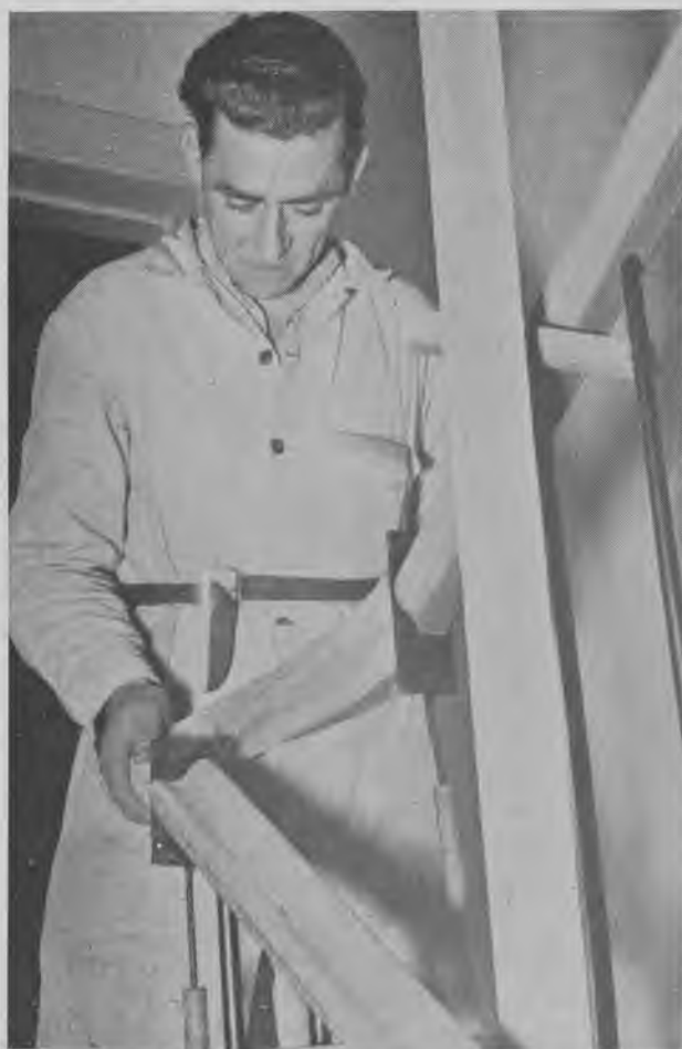
Fig. 1305. Svinget er kehlet færdigt på undersiden og varmes nu i fugerne, klar til limning.
