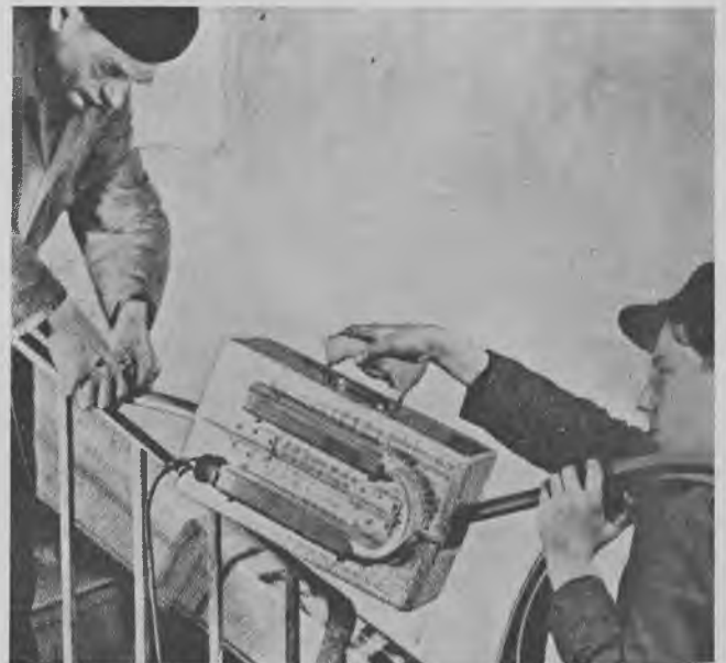
Fig. 1314. Ved hjælp af en elektrisk varmekasse opvarmes plastic-håndlisten og anbringes på jernskinnen. Når afkølingen har fundet sted, er listen hård og mere slidstærk end træ.
