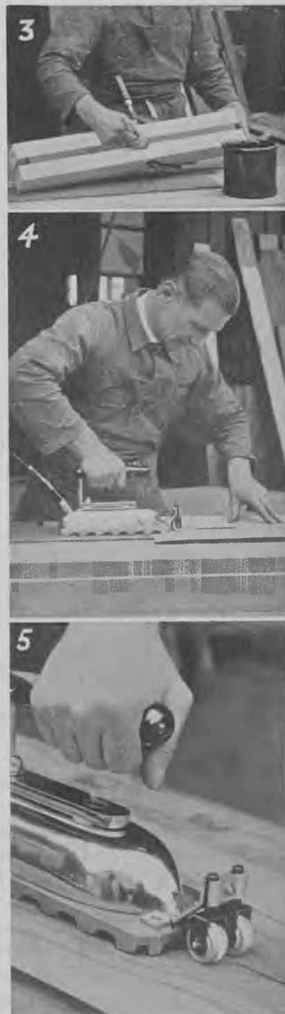
Fig. 1841 b. 3: De fugede finéer påføres lim (i fugemaskinen eller mellem fugebrædderne). 4: »Sammensætningen« begynder. 5: De skråstillede hjul sammenpresser finéerne, til limen er hærdet.
