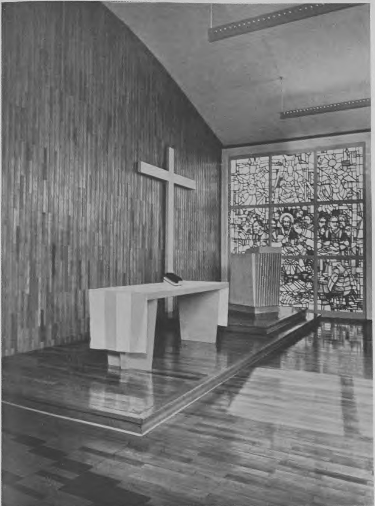
Fig. 1245. Bøgeparket anvendt til væg og gulvbeklædning i et kirkerum (Duisburg). (Efter A. C. Rüdener: Holz im Raum).
