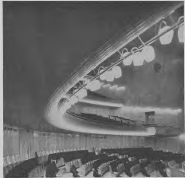
Fig. 1250. Statsradiofoniens koncertsalsstudie, København. Arkitekt M.A.A. Vilh. Lauritzen. Vægpanelerne er udført i møbelplader, der er finéret med ahorn og med ahornskantlister. Udbygningen, på balkonen, er kongelogen. Loftet er beklædt med 41000 meter bøgetræslister.
