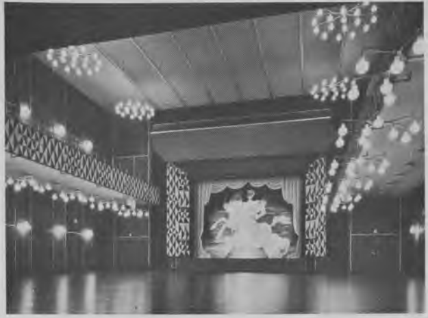
Fig. 1249. Folkets Hus, Enghavevej, København. Arkitekt, M.A.A., Vilh. Lauritzen. Vægpanelerne er udført i novopanplader, der er kantlimet og fineret med Bangkok teak. Panelerne er ophængt med blindlister i et hvidlakeret fyrretræsstel, der er fastgjort på muren. Figurmotiverne på balkonen og prosceniet er udført af 3 tykkelser, som er krydslimet, derefter er hver enkelt figur udskåret, pudset, kanten brækket ganske lidt, bejdet og pålimet en møbelplade.
