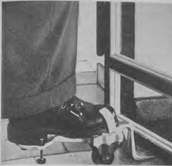
Fig. 1836. Illustration, der viser dørhæverens anvendelse.
