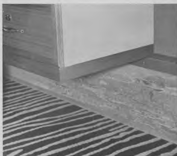
Fig. 1506. Detaille af ophængning af chatol.
