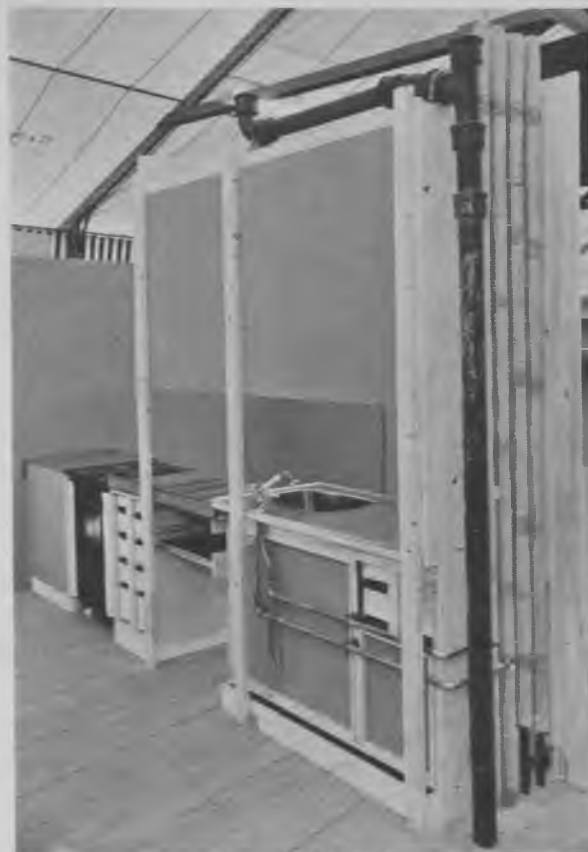
Fig. 1268. Alle rør ligger skjult. (Fra »Bygge- og Boligudstillingen« på Bellahøj 1953).
