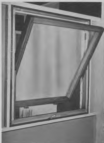
Fig. 1069. Rammen i tyngdepunktslejet.
