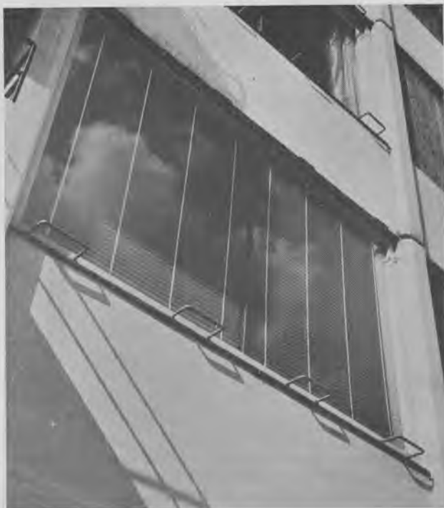
Fig. 1029. Pudsebøjler til brug ved vinduespudsning. Bøjlerne er indboret i karmnakken og fastgjort ved 1 stift eller en skrue fra karmtræsfladen og ned igennem et hul i bøjlen. Da bøjlerne bruges til at stå på – de øverste til at holde sig fast i – må de være meget omhyggeligt indboret og fastgjort (mindst 70 mm ind i karmen).
