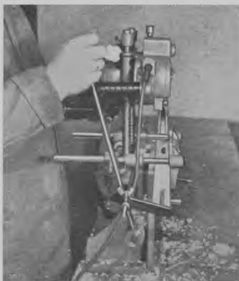
Fig. 1748. A: Udstemning for skabshængsler. B: Udstemning for sprosseshuller. (»MAKA«, Chr. Andersen Bygningsmaterialer A/S).
