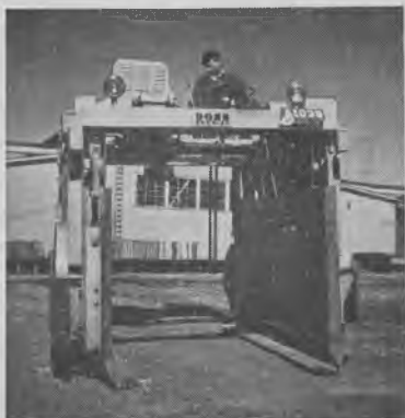
Fig. 1374. Truck med løfteanordning i bundstilling = lastestilling.
