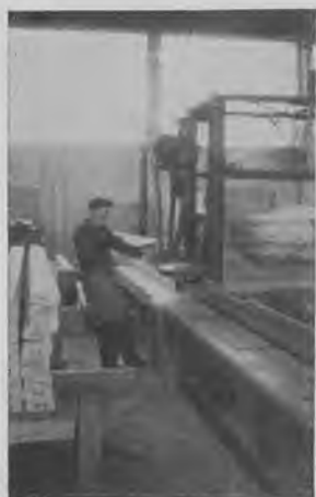
Fig. 1381. Maskine for afkortning og tapning af tømmer.
