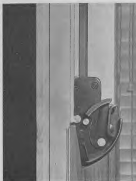
Fig. 1059. Pivothængsel i karm.
