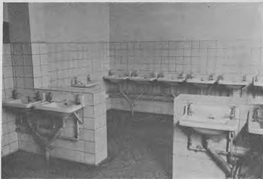
Fig. 792. Smukt indrettet vaskerum med velholdte fajancekummer, som imidlertid kun er velegnede til forholdsvis pro-pert arbejde. Til- og afløbsrør er dog stærkt udsatte for tilsmudsning. (Arbejds-tilsynet).
