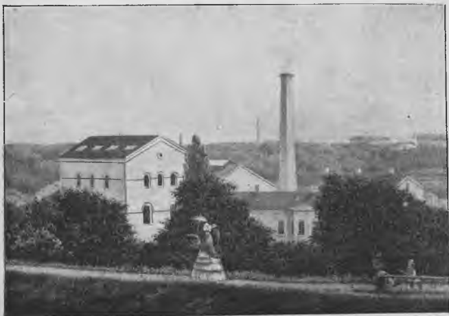
Vandværket med Volden.
