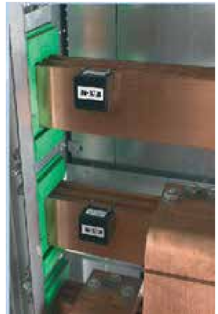
תמונה 5: חיישני הטמפרטורה מעבירים נתונים אל הבקר בצורה אלחוטית כל 10 דקות או במייד (תלוי בהגדרות המערכת)
