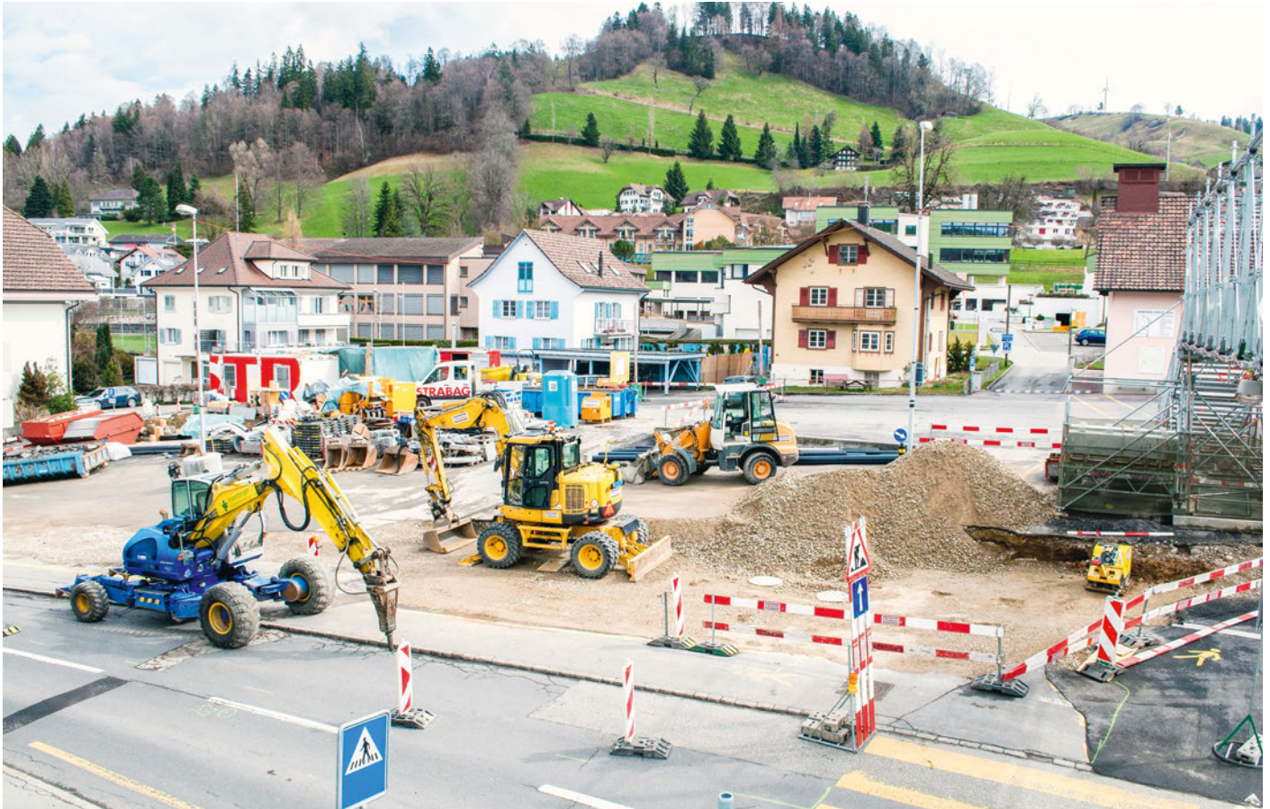
Es wird gebaut in Entlebuch: Am Marktplatz wird die Kantonsstrasse 10 saniert.
