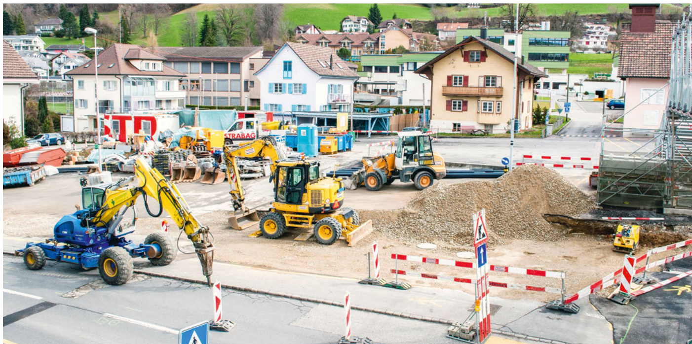
Entlebuch est en chantier: près de la place du marché, la route cantonale 10 est en cours d'assainissement.
