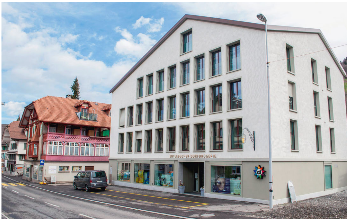
Revitalisation du centre du village à Entlebuch: pour construire la nouvelle « maison des tireurs » (bâtiment avec la droguerie), il a fallu démolir quatre vieilles maisons.
