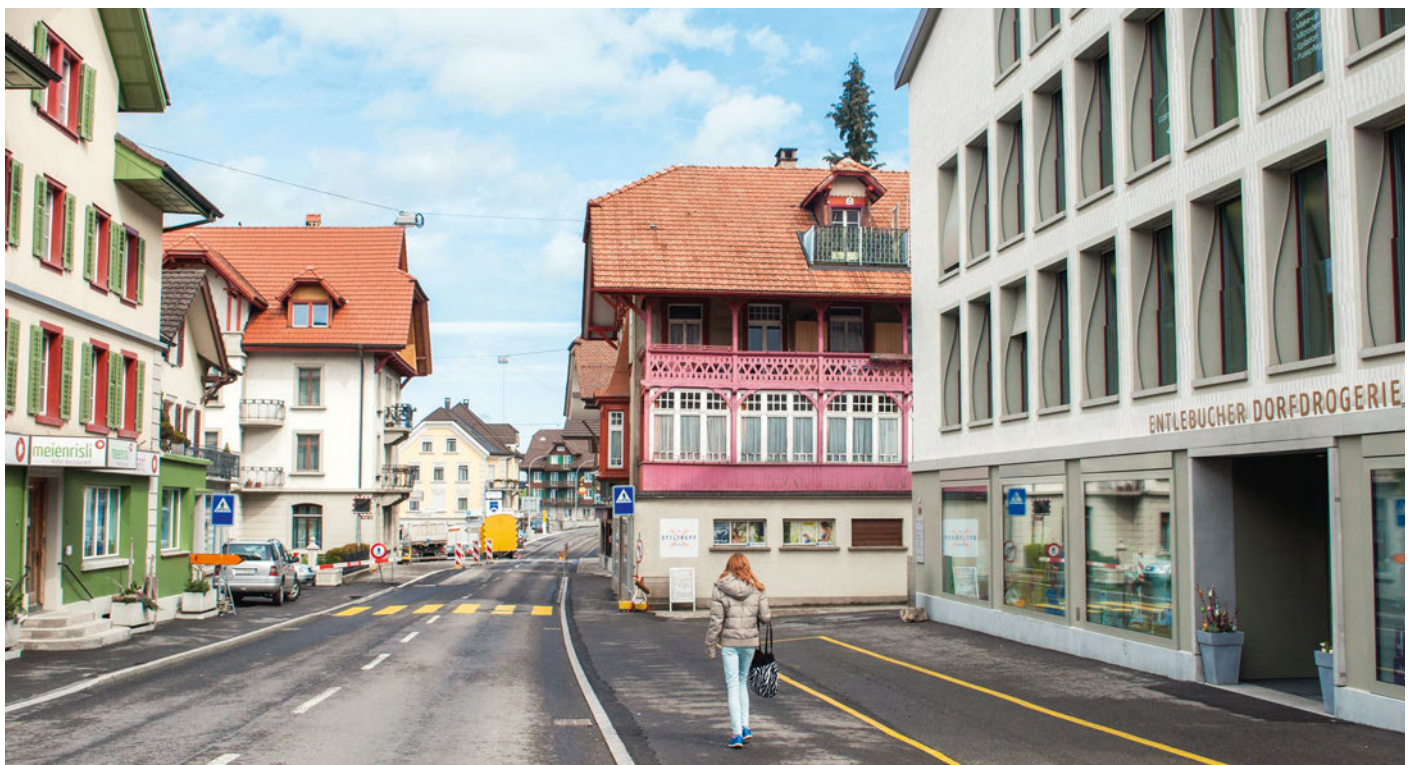
Erneuerung des Dorfkerns in Entlebuch: Um das neue Schützenhaus (Gebäude rechts mit Drogerie) zu bauen, mussten vier alte Gebäude weichen.
