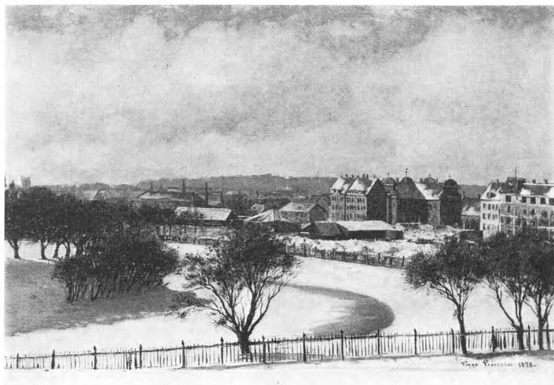
Ørstedsparken set fra N. Zahles skole 1878, inden Teknisk skole i Ahlefeldtsvej blev bygget. T. h. Frederik den 7.s stiftelse i Gyldenløvesgade, t. v. Marstrands bryggeri på Vodroffsvej. Maleri af Viggo Pedersen 1878.
