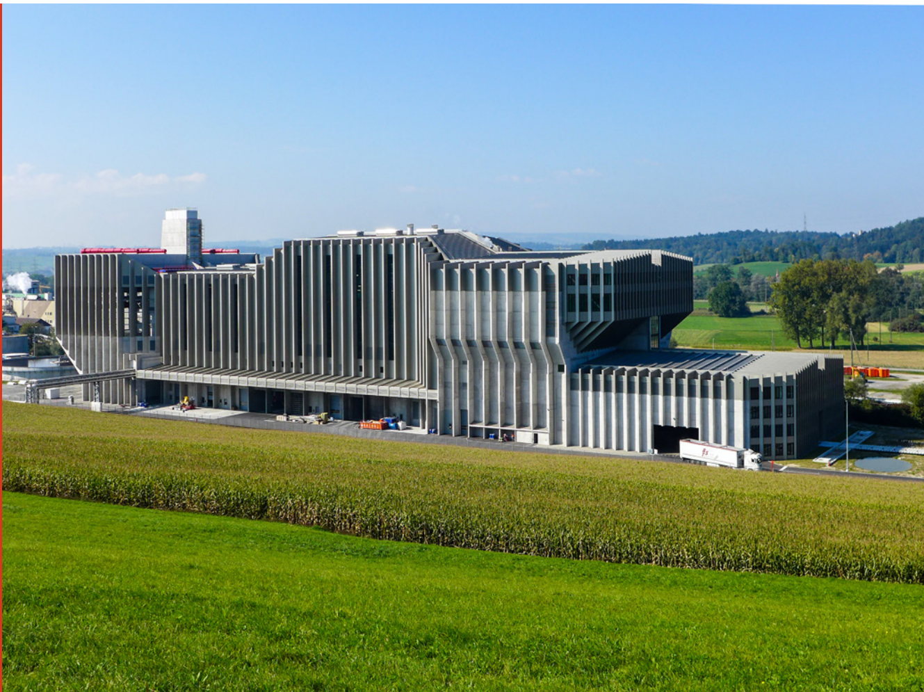
Kehrichtverbrennungsanlage Perlen/Root (Quelle Foto: Renergia Zentralschweiz AG)
