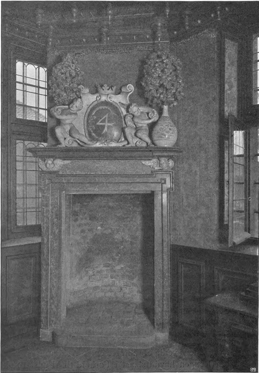
Kamin i Christian IV.s Taarnkammer (Skrivekammer). Vingerne paa Genierne ved Siden af Skjoldet og paa Basunenglene er udført i farvet Gips.
