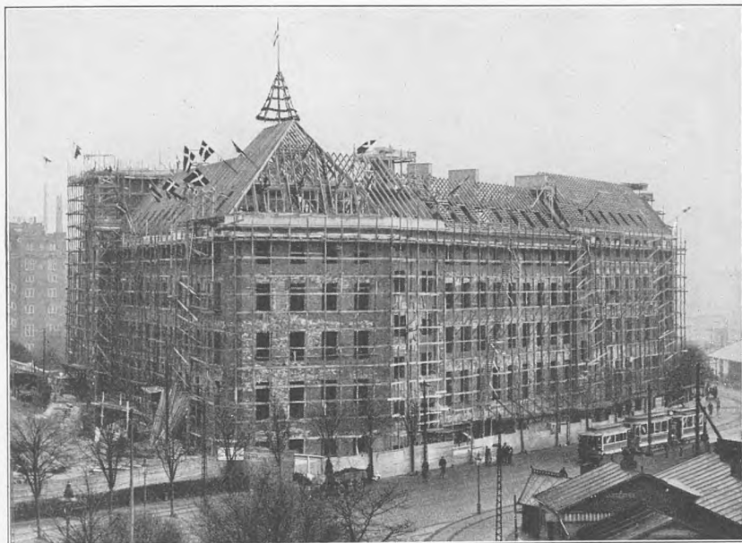
Teknologisk Instituts Bygning under Opførelse.
