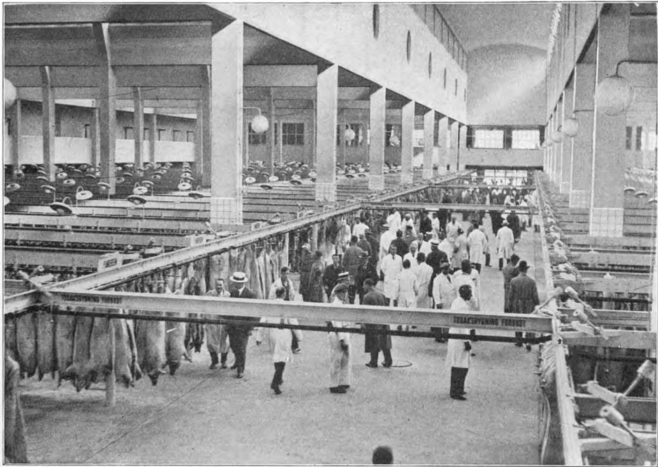
Salgshallen for Kød og Flæsk. (Gulvflade: 7850 m 2 ; Ophængningsplads til 7000 Kroppe).
