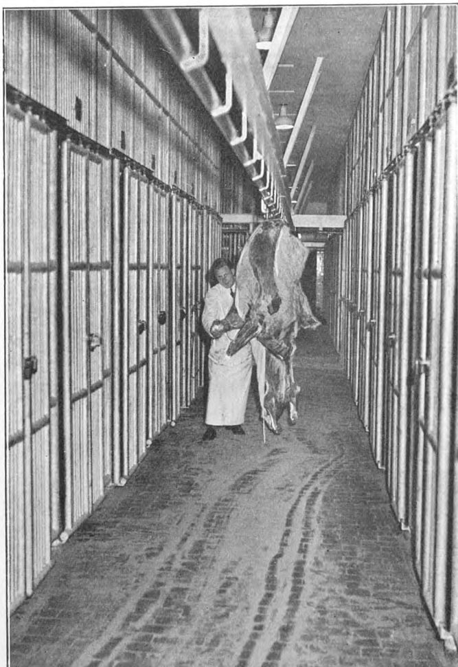
Gang imellem Kølehusets Celler. (Gulvflade: 665 m 2 ; Antal Celler: 100).
