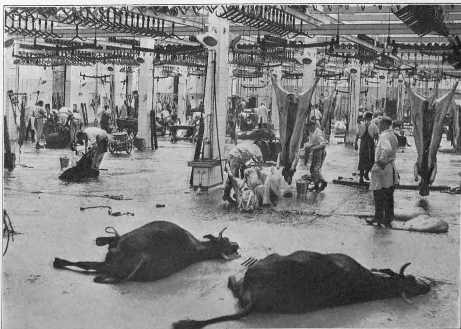
Slagtehallen. (Gulvflade: 2000 m 2 ).
