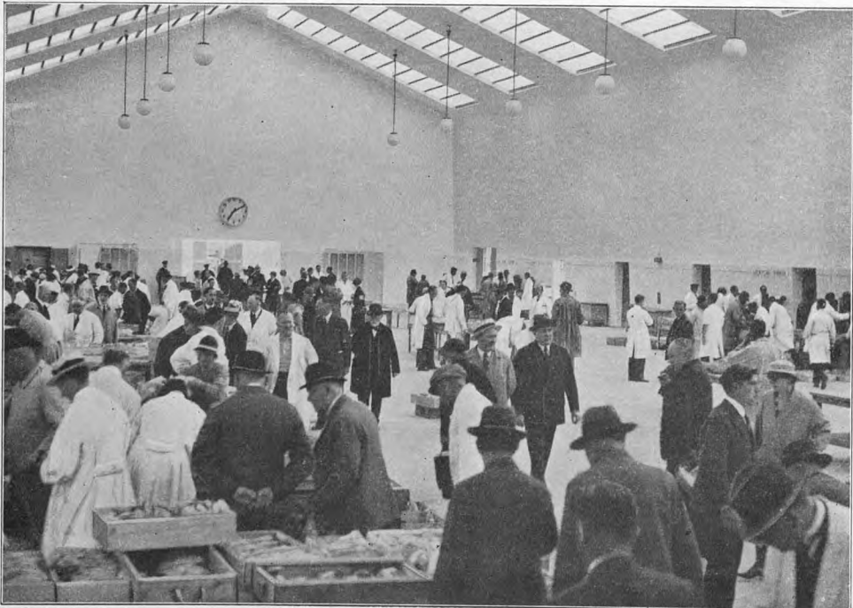
Fjerkræhallen. (Gulvflade: 1365 m 2 ).
