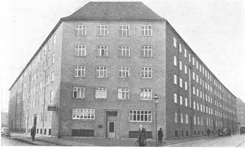
Trekanten, Arresøgade, Tagensvej.
