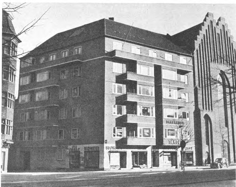
Dansk Tømrerforbunds hus, hjørnet af Tømrergade og Åboulevarden.
