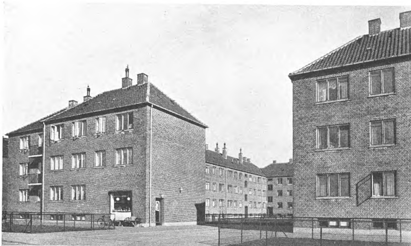
Københavns social-filantropiske Boligselskab på Høfdingsvej.
