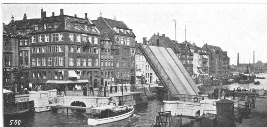
Nyhavnsbro — Elektrisk Løftmaskineri
