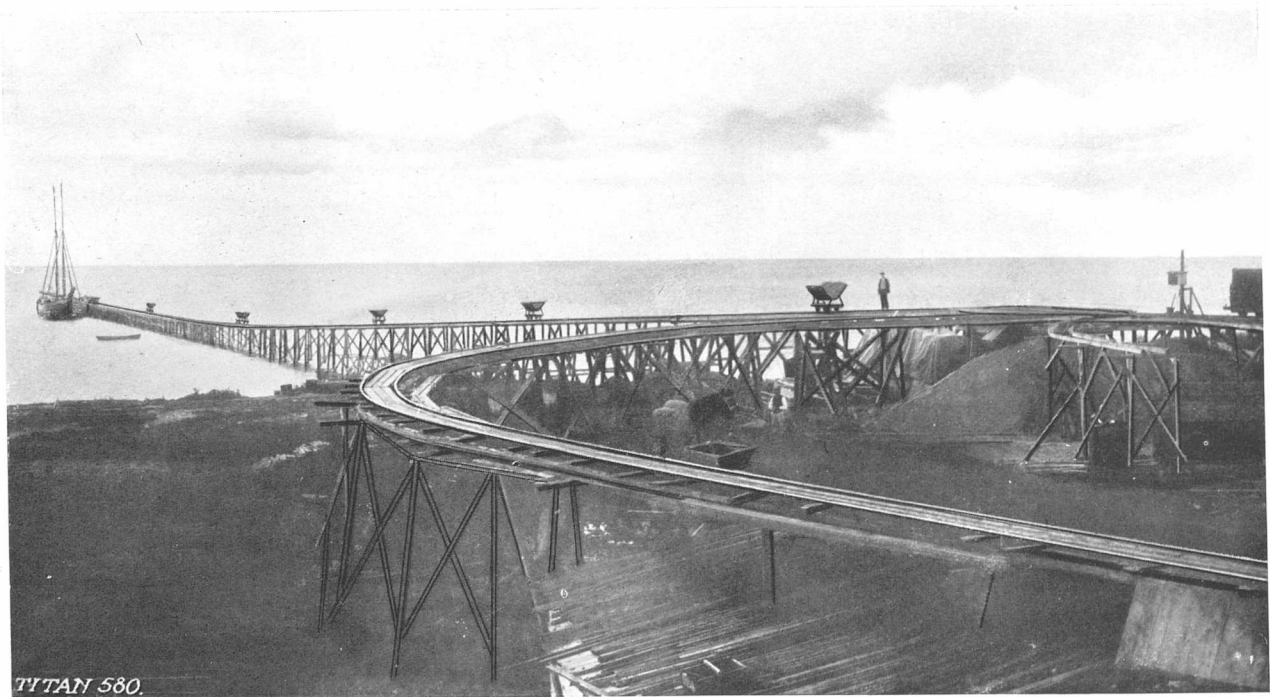
Kabelbane til Transport af Jord ved et Jordarbejde
