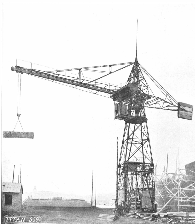
Eriksbergs mekaniska Verkstads Aktiebolag, Göteborg — 3 Tons Beddingskran
