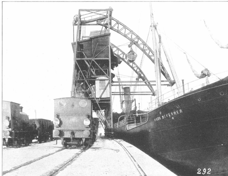
Københavns Østre Gasværk — 2 Huntkraner til 1 Ton Gribeskovl Kapacitet pr. Kran indtil 80 Tons pr. Time
