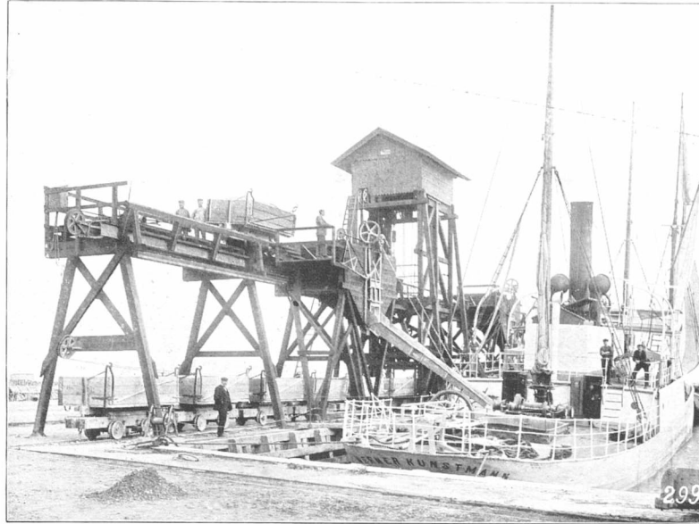
Akts. Faxe Kalkbrud — Indladningsmaskineri for Kalksten
