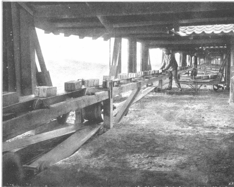
Akts. Frederiksholms Tegl- og Kalkværker 3 Baandtransportører, Længde 100 à 130 Meter
