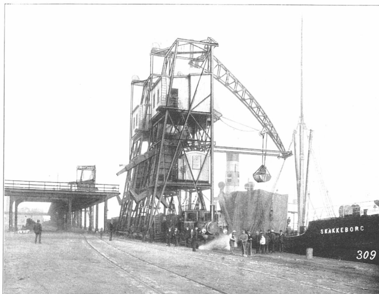
Københavns Valby Gasværk — 2 Huntkraner til 1 Ton Gribeskovl Kapacitet pr. Kran indtil 80 Tons pr. Time
