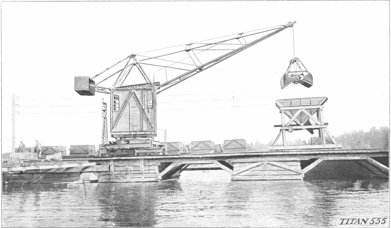
A/B Iggesund Cellulosefabrik, Sverige
