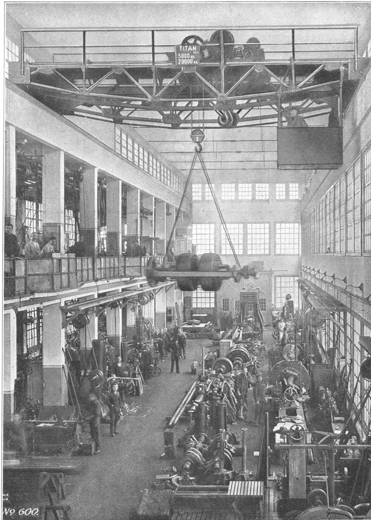
Orlogsværftet — 20 Tons elektrisk Løbekran
