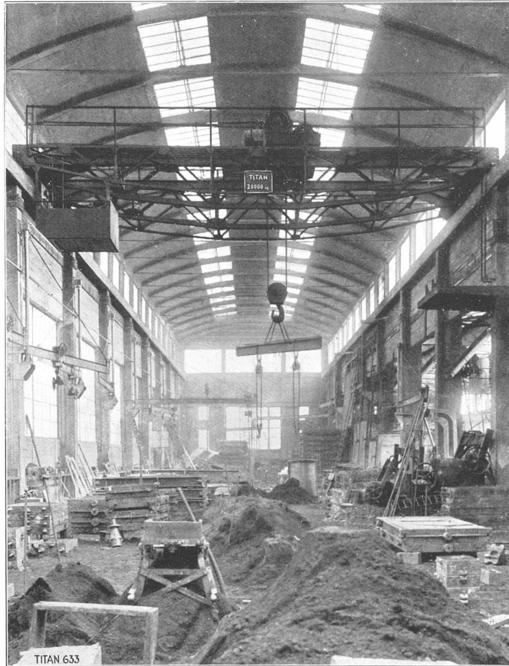
A/S Københavns Flydedok og Skibsværft — 20 Tons elektrisk Løbekran
