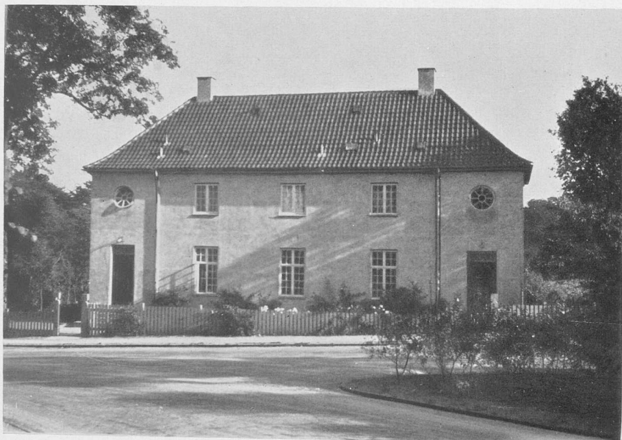
Central Rungsted, Rungstedvej 2. Opført 1925.
