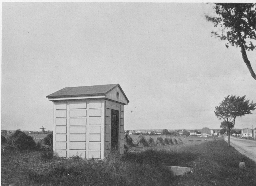
Kabelhus ved Ringsted.
