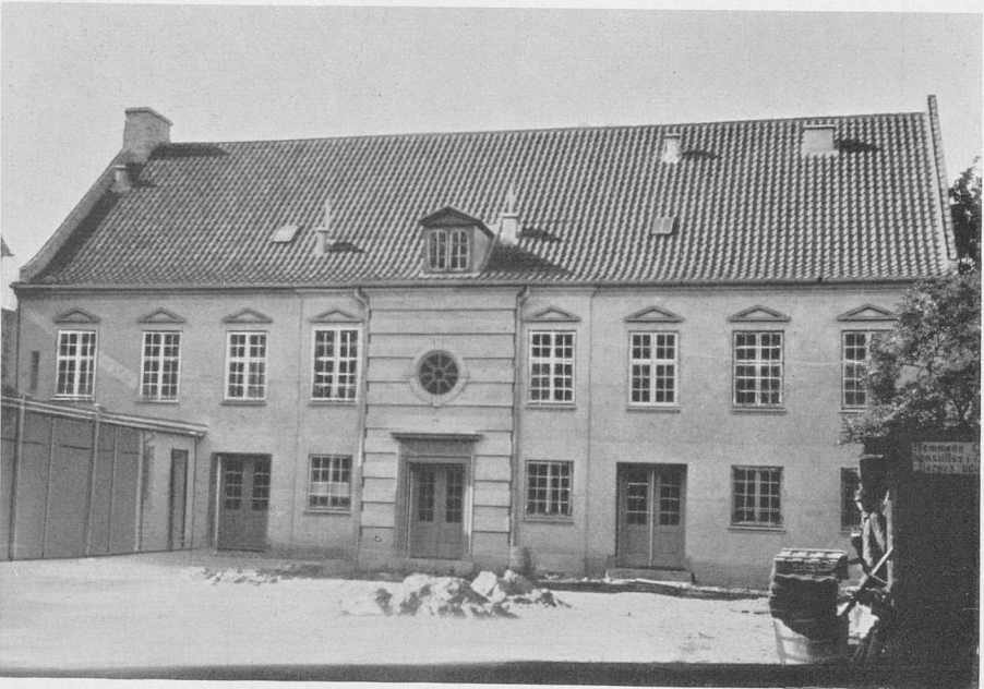
Central Køge, Torvet 21. Opført 1929.
