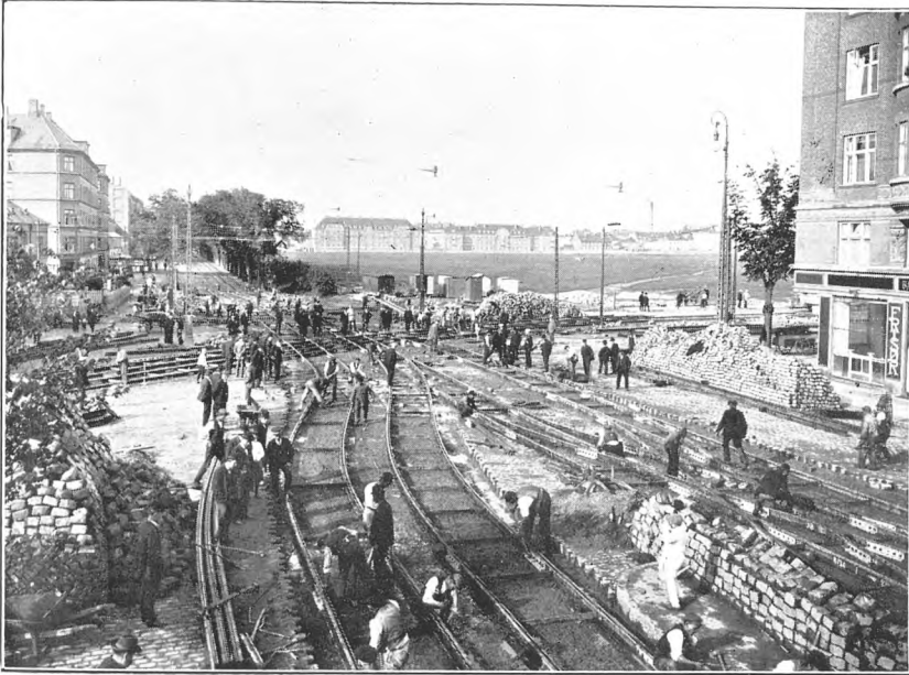
Anlage einer Strassenbahn.
