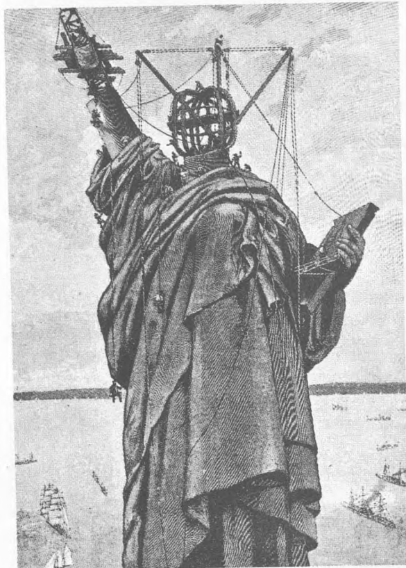
Frihedsstatuen nogle faa Uger før Arbejdets Afslutning. Endnu mangler Beklædningen af Hovedet og Armen med Fakklen. Bemærk, hvor bittesmaa Arbejderne er i Forhold til Statuen.
