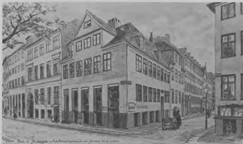
Flådemalerens bolig 1746–1757 på hjørnet af Skindergade og Niels Hemmingsensgade. Dette typiske ildebrandshus byggedes ca. 1735 af malerlavets oldermand Marcus Cardes. J. L. Ridter udførte sin akvarel år 1900 kort før nedrivningen. Butiksindretningen i stue og kælder har ændret den oprindelige vinduesinddeling. (Bymuseet)
