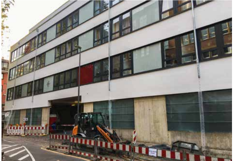
Bald wird auch die Baustellenabspernung entfernt
