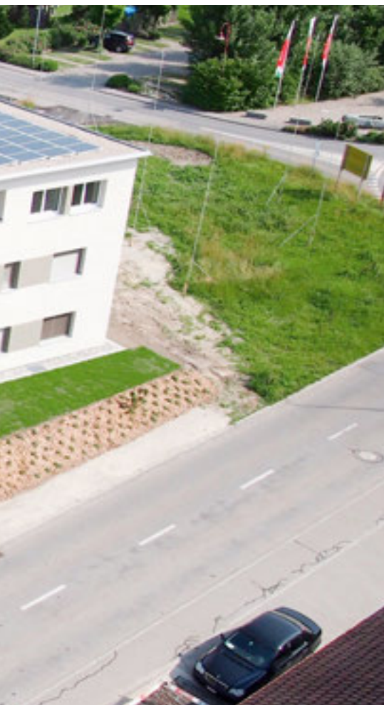
L'eau chaude est encore souvent produite par des capteurs solaires thermiques.
