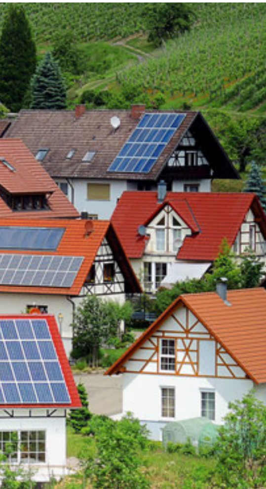
Warmwasser wird häufig noch über thermische Sonnenkollektoren erzeugt.
