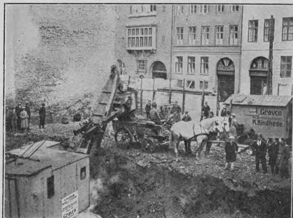
Nørregade Nr. 16 efter Nedrivningen 1928. Grunden graves ud.
