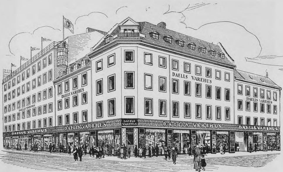
Varehuset, som det saa ud endnu i Begyndelsen af 1934.
