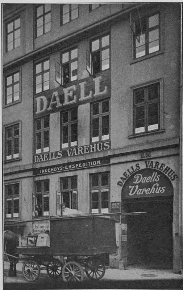
Studivstræde Nr. 21, hvor vi begyndte Forretningen.
