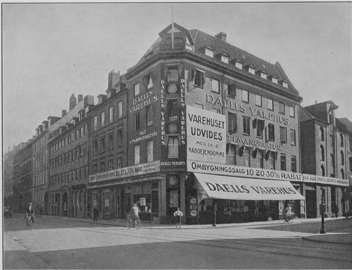
Nørregade Nr. 14 og 12 og Krystalgade Nr. 30 under Ombygningen. 1923.
