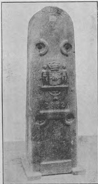
En Prøvekasse fra 1852. Benyttet ved den første danske Telegraflinie; var anbragt for hver \frac{1}{4} Mil.
