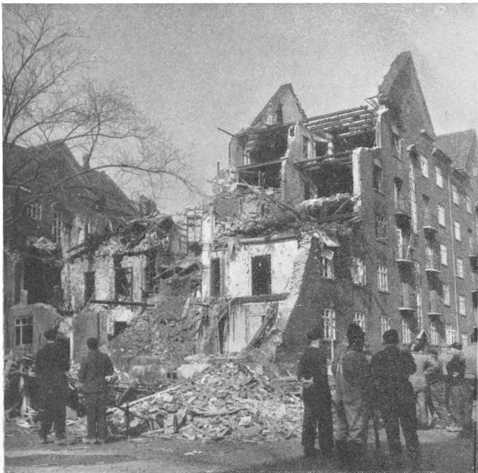
Ødelæggelser på Sønder Boulevard ved luftangrebet på Shellhuset i marts 1945.
