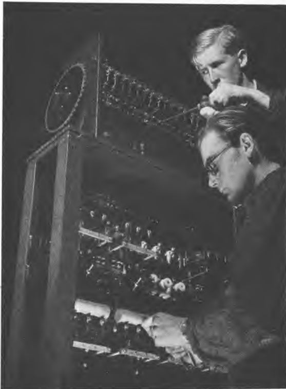
Montage af Elevator-Kontroller.
