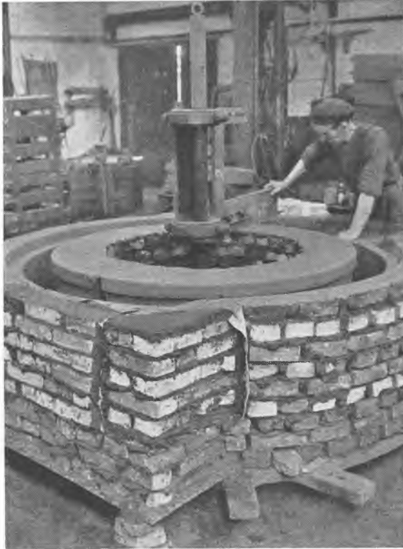
Støbeform bygges op.
