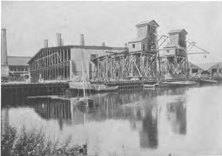
De to Hunt'ske Elevatorer ved Vestre Gasværk. Det første Kullosningsanlæg her i Landet, udført af Marstrand, Helweg & Co. Aar 1893. Fotografi i Bymuseet.
