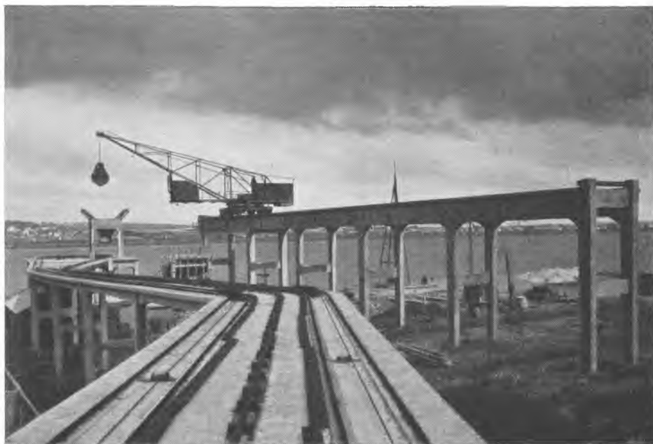
Kørende Svingkran paa Betonbro.
