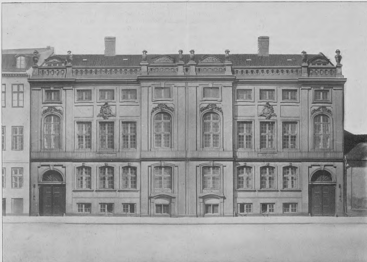
Palæerne Amaliegade 15 og 17 forinden førstnævnte skamferedes ved den nedenfor viste Ombygning.
