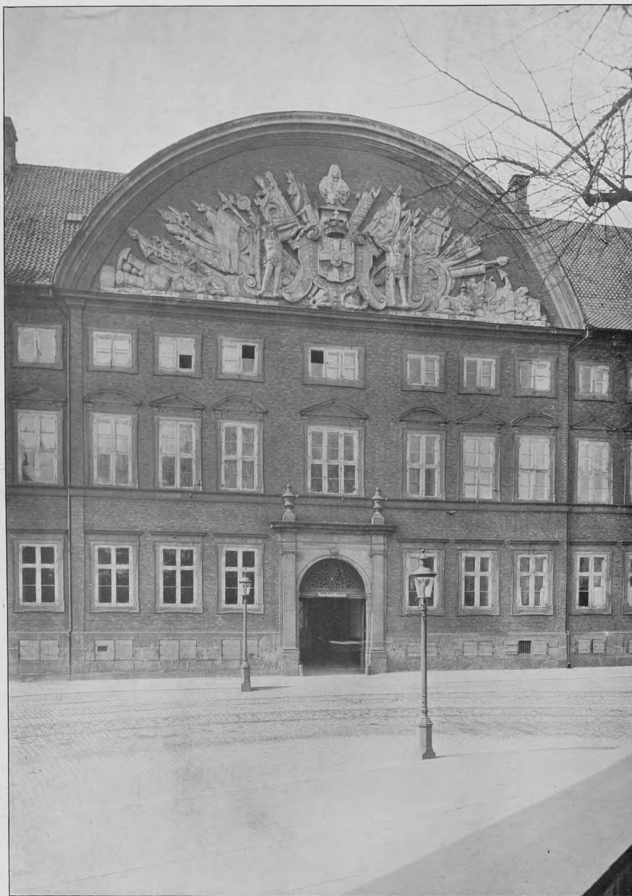
Kancellibygningen: Parti af Hovedfaçaden mod Slotsholmsgade.
