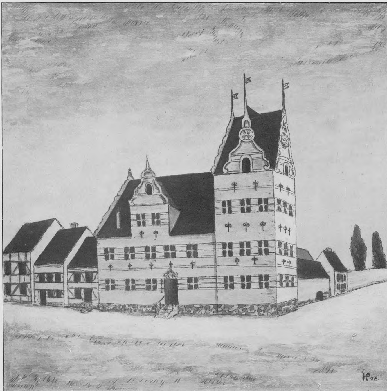
Hjørnet af Gammeltorv og Nørregade Aar 1611. Ejendommen, kaldet „Blasen“, sprængtes under den store Ildebrand 1728 i Luften. Se Teksten Side 278.
