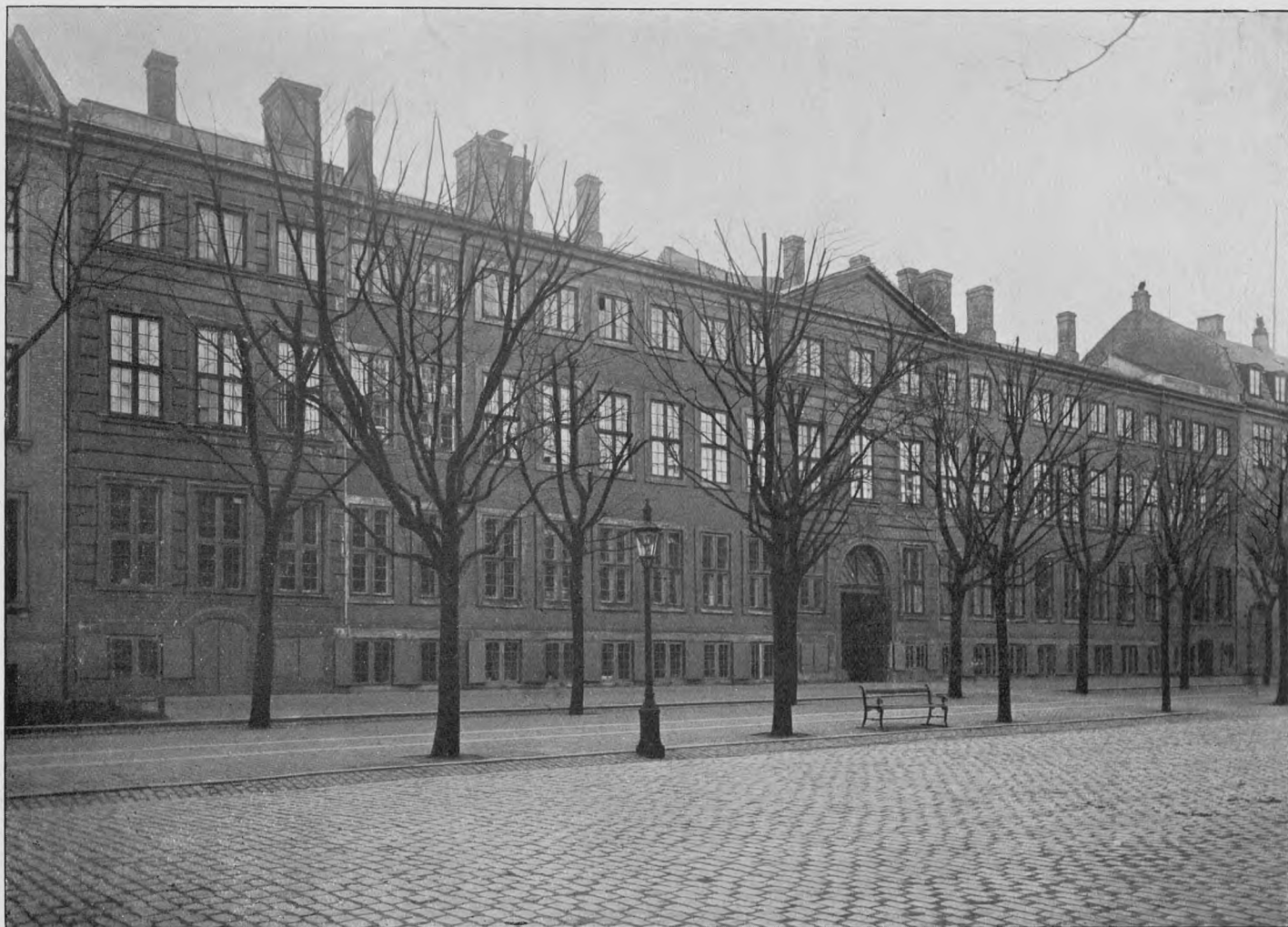
Det Würtembergske Palæ (Lerches Gaard): Hovedfacade mod Slotsholmsgade.
