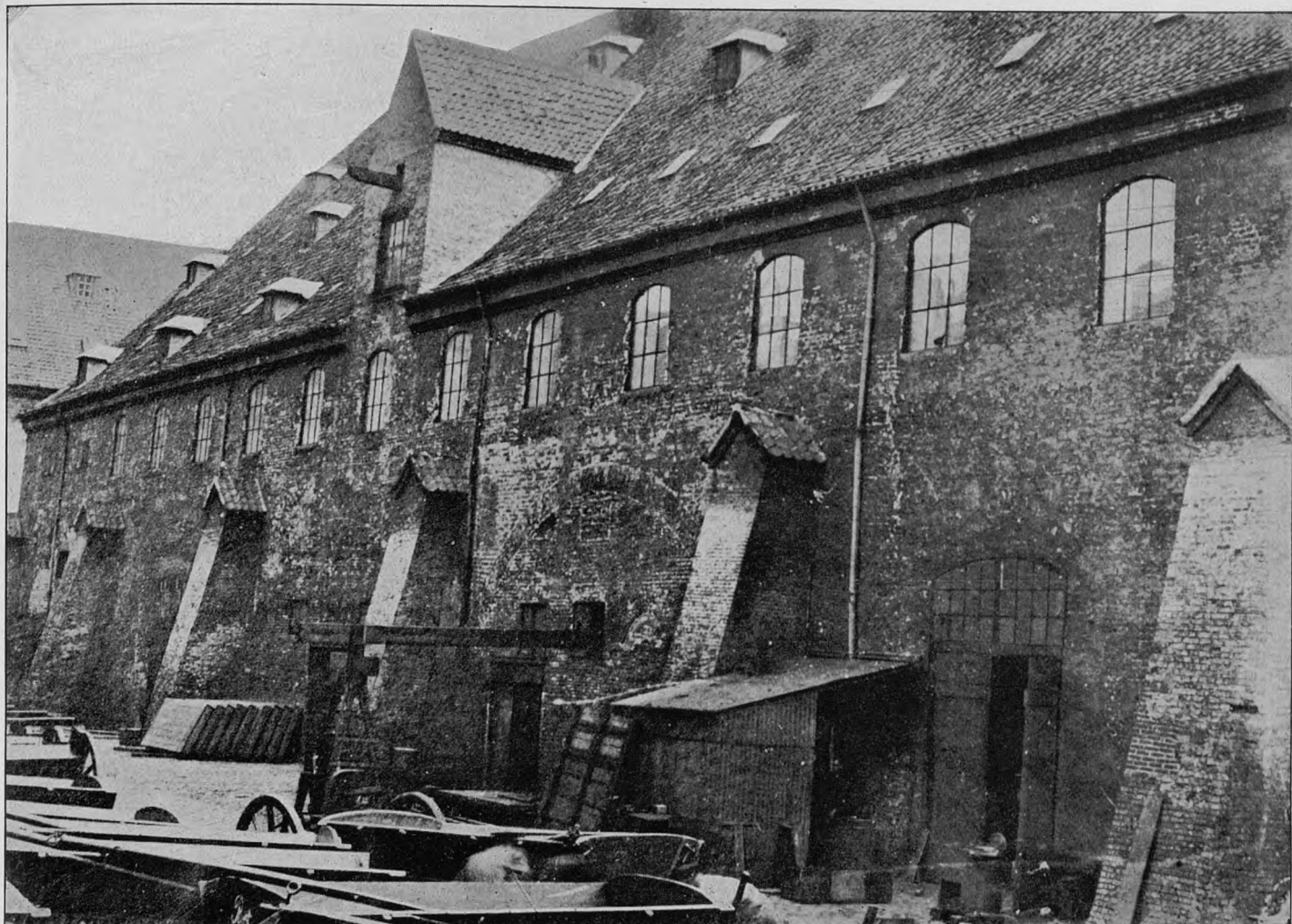
Chr. IV's Galejbygning brugt som Værksted og Seletøjsmagasin, ca. 1880, set fra Nord.
