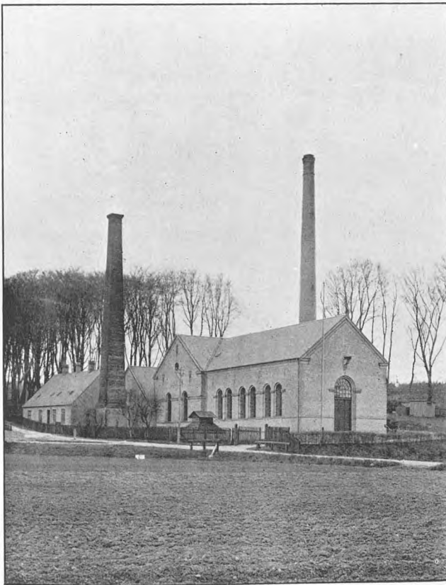
Maskinhus ved Søndersø.
