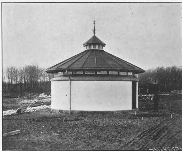
Overbygning over Samlebrønden.
