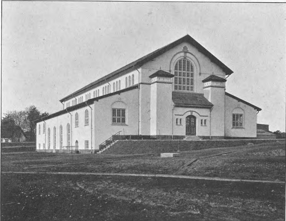
Maskinbygningen ved Thorsbro.
