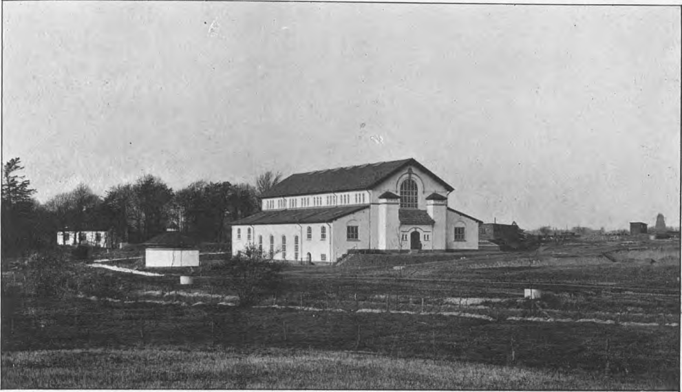
Vandværkspladsen ved Thorsbro.
