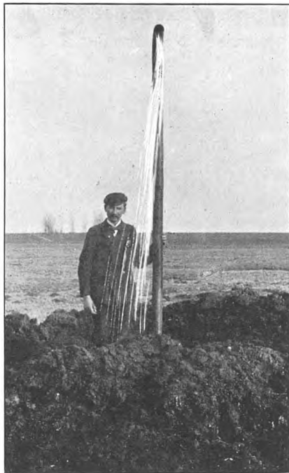
Undersøgelsesboring ved Ishøj.
