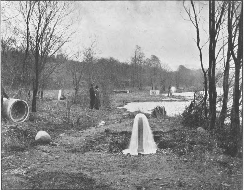
Boringer ved Søndersø.
