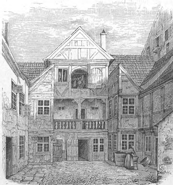
Den Collinske Gaard i Bredgade. Efter Traps Topogr. II, 27.
