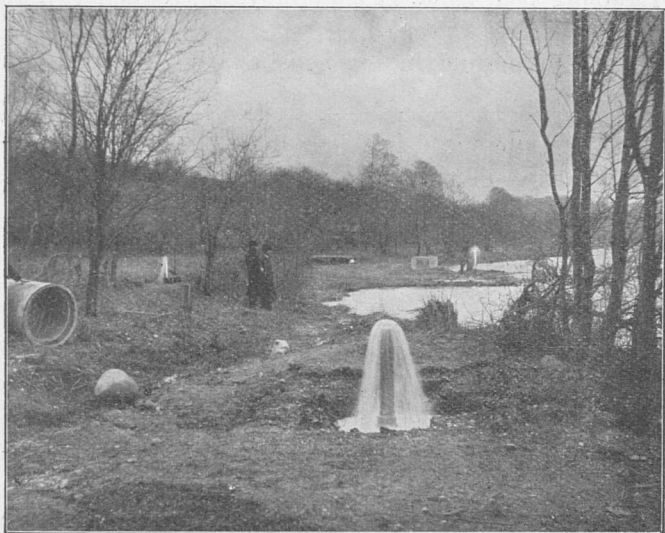
Boringer ved Søndersø.
