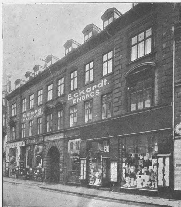
Ejendommen Købmagergade 60, hvor Firmaet Georg Eckardt har Lokaler.
