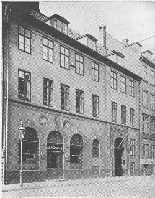
Johan Fr. Schalburg, Facaden mod Stormgade.
