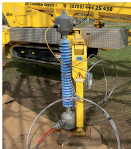
▼ Bild 9: Komplett montierter Trenner vor dem Heben
