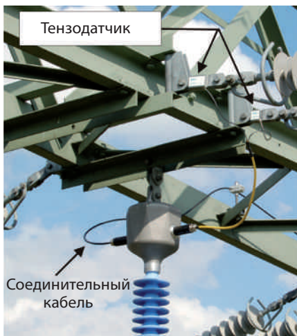
▼ Рис. 10. Верхняя часть разделителя с кабельными вводами
