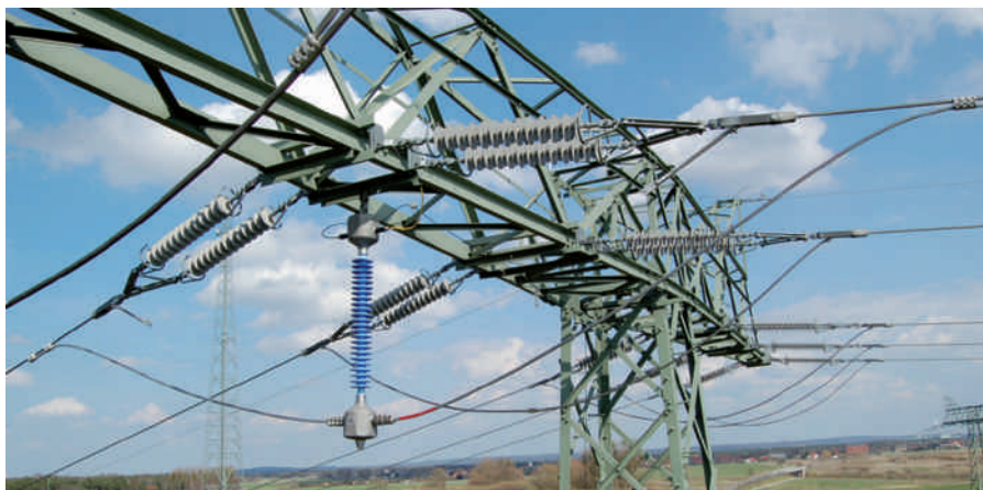
▲ Figura 11: Sistema di controllo della temperatura e della deformazione completamente assemblato
