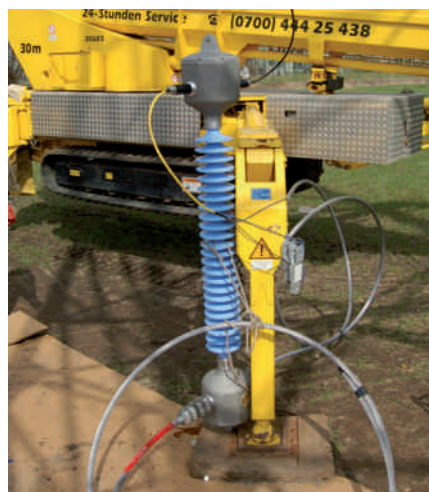
▼ Figura 9: Separador completamente ensamblado antes del levantamiento
