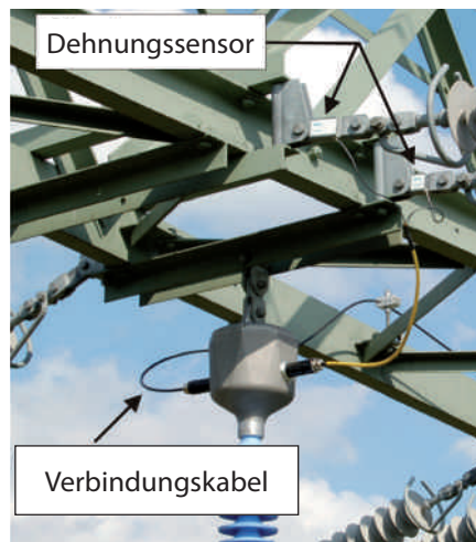
▼ Bild 10: Trennerspitze – Detail des Kabeleinlaufs
