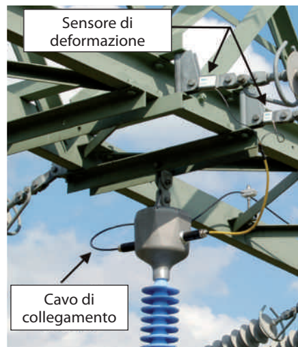
▼ Figura 10: Parte superiore separatore - dettagli ingressi cavi
