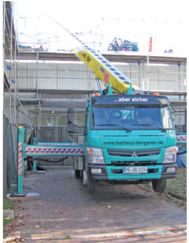
Sicherheit geht vor: Auch wenn die Absperrung für eine halbe Stunde Arbeitseinsatz mal drei Stunden beansprucht.
