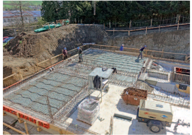
Während der Spatenstich erfolgte, wurde schon die Bodenplatte gegossen.
