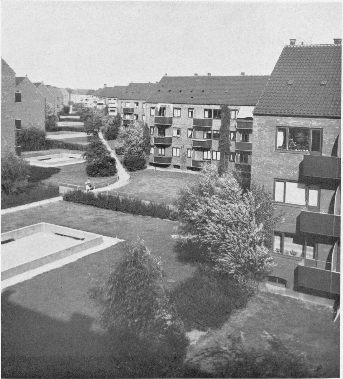
„Ryparken“ med Stokbebyggelse, opført i 1930'erne. De store Indlemmelser gav Plads for en mere aaben Bebyggelse.
