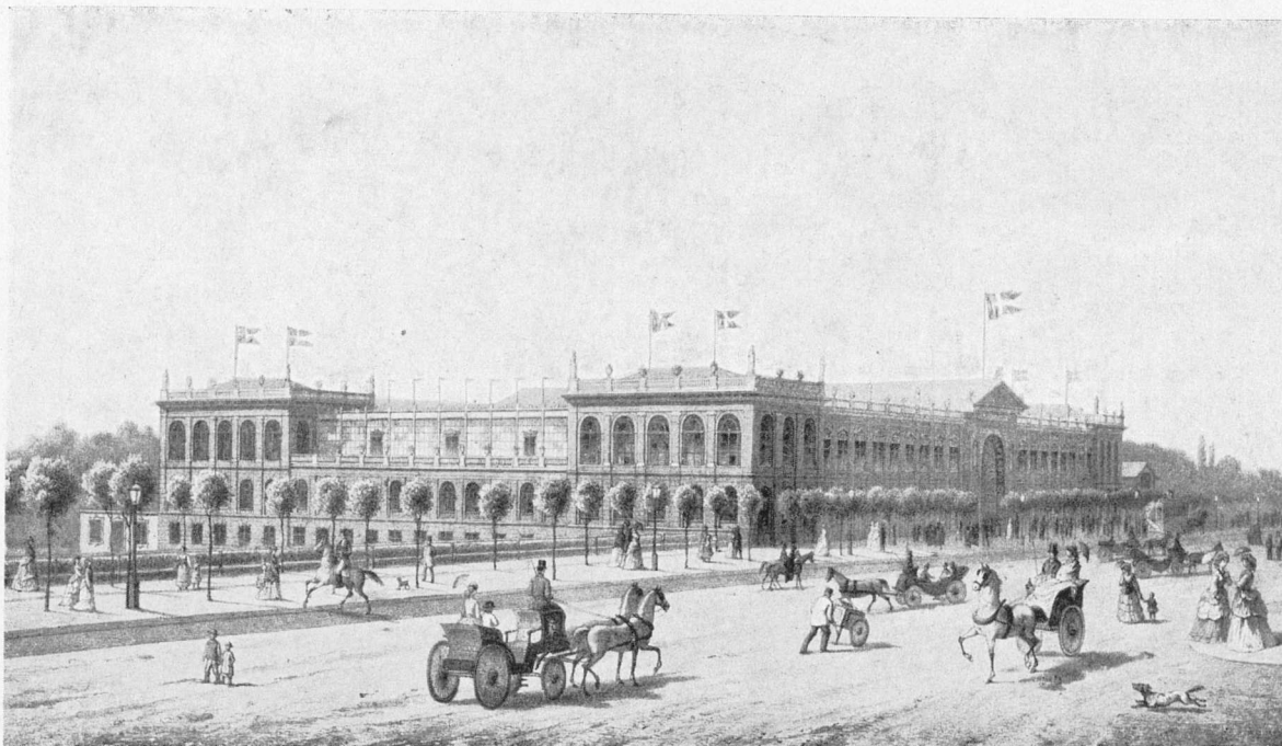
Industriforeningens Bygning, opført 1870—1872.
