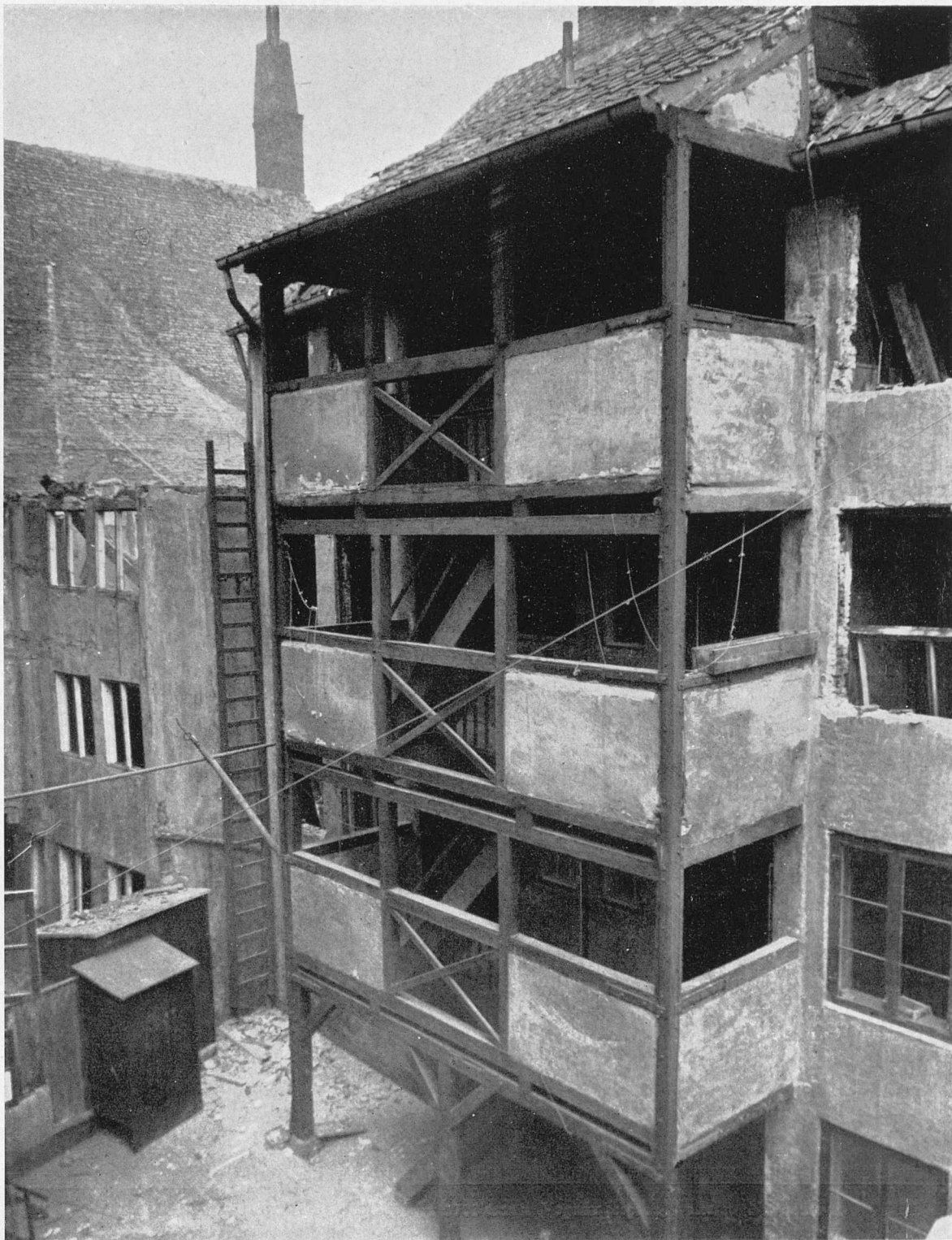
Udvendigt Trappe-Anlæg i tre Stokværk fra 1700'erne i Vognmagergade-Kvarteret. Nu nedrevet.
