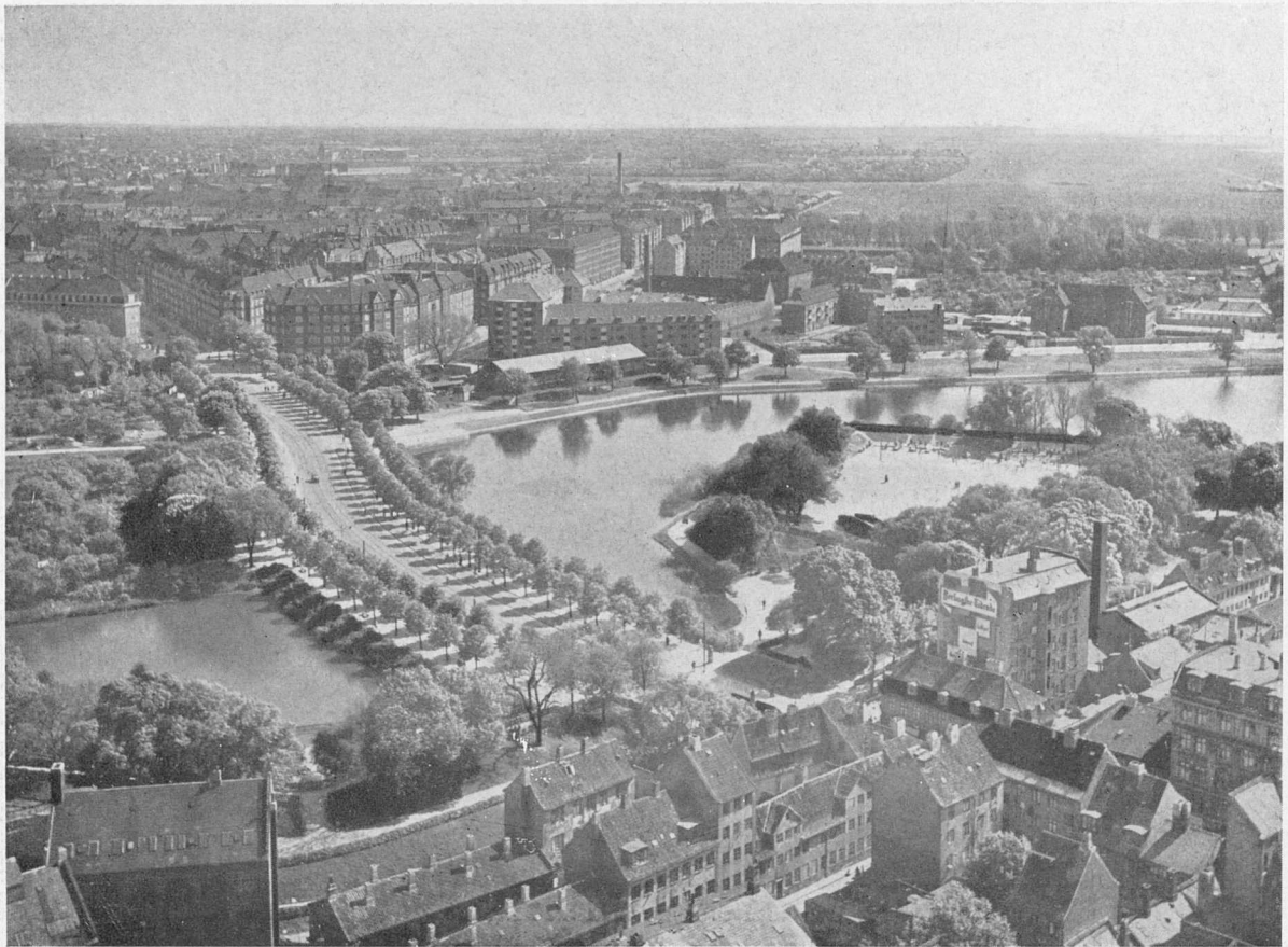
Amagerbrogades Overførsel over Voldgraven, set fra Luften.
