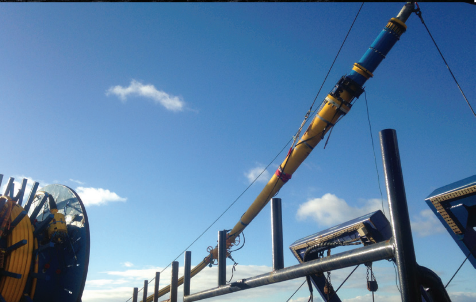
在Fukushima海上漂浮风力发电场演示连接器被安装到电缆上
