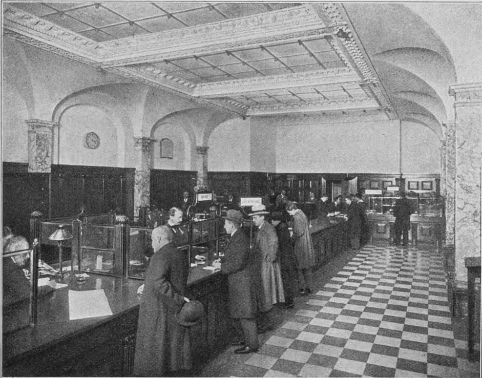
Hovedkontoret efter Ombygningen. (Den overbyggede Gaard.) Indbetalingen
