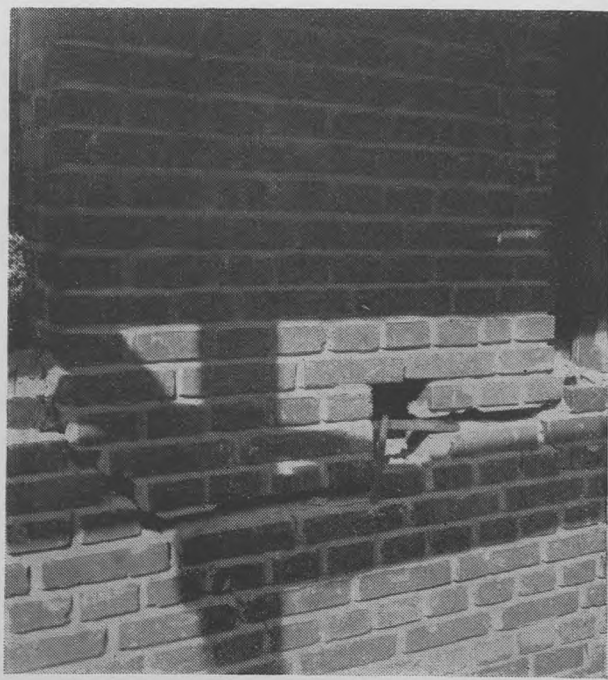
Billederne viser, hvorledes Ydermurenes Murværk indtil Vinduesoverkanten er skudt ud af sin lodrette Stilling, medens den øverste Del af Bygningens Ydermure er holdt tilbage af Tagkonstruktionen.
