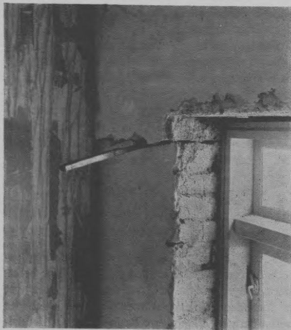
Billederne viser de tilsvarende Frostsprængninger set inde fra Bygningen, hvor Forbindelsen mellem Tværskillerummene og Ydermurene er sprængt.
