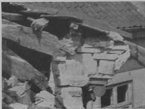
Billedet giver et Indtryk af Hovedgesimsens daarlige Tilstand.
