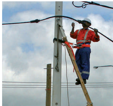
▼ Figure 10: Installation aérienne d'un conduit multitube
