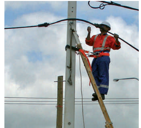
▲ Рис. 10. Монтаж подвесной секции кабельных каналов из нескольких труб
