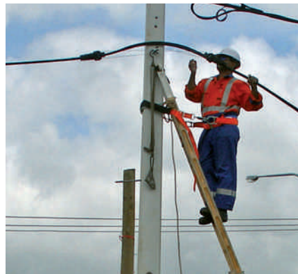
▼ Figura 10: Instalación aérea de un conducto multitubo
