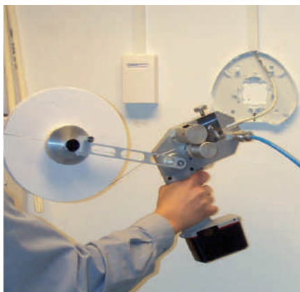
▼ Bild 13: Installation vorverbundener EPFU
