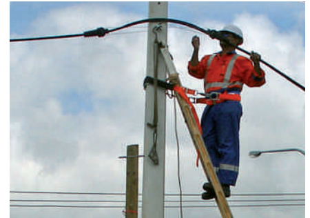
▲ Bild 10: Installation eines Multi-Leitungsaufbaus für Freileitungen
