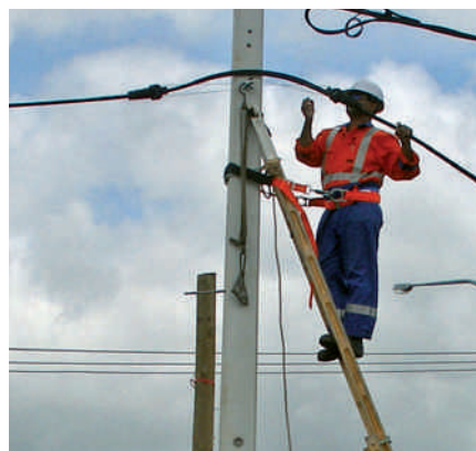
▼ Figura 10: Installazione aerea di un condotto multitubo
