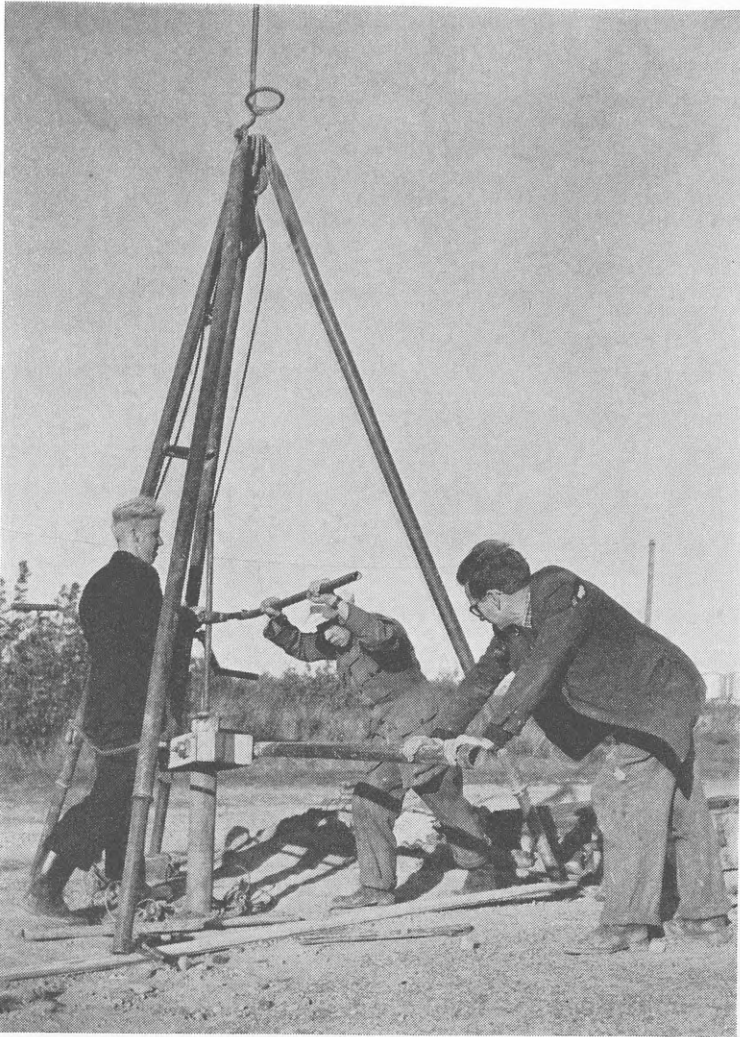
ET AF INSTITUTTETS BOREHOLD I ARBEJDE
