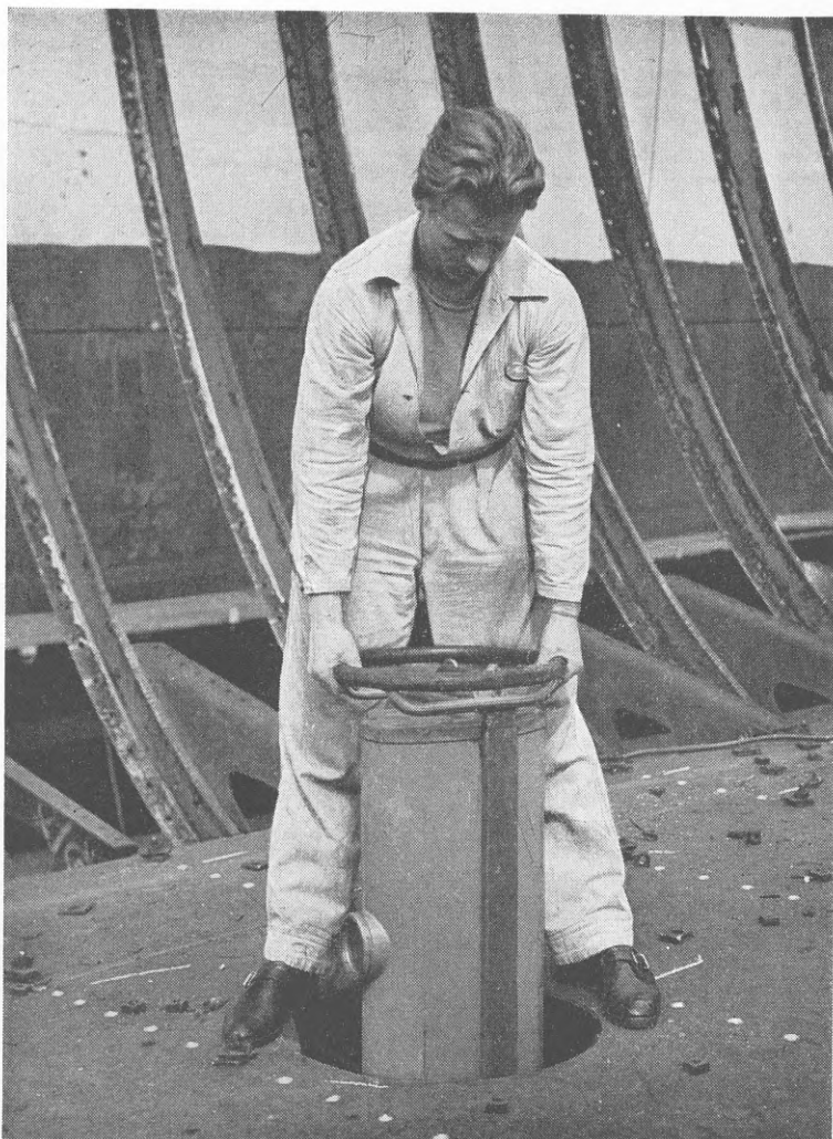
VED HJÆLP AF LETTE RØNTGENANLÆG FORETAGER SVEJSECENTRALEN UNDERSØGELSER SELV PÅ DE VANSKELIGST TILGÆNGELIGE STEDER SOM F. EKS. OMBORD PÅ ET SKIB UNDER BYGNING
