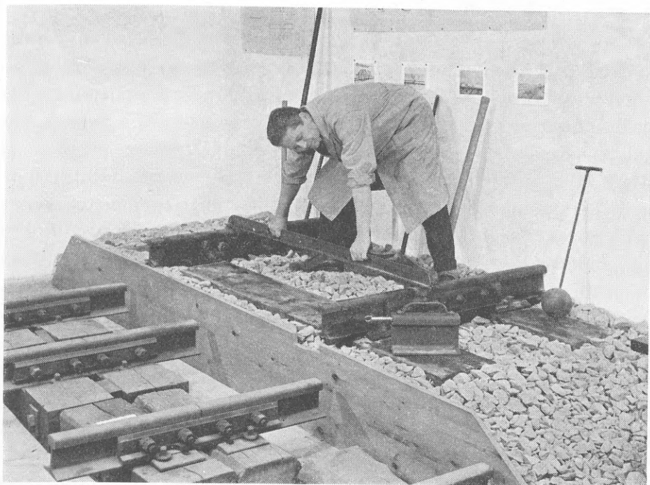
EN DEL AF SAMLINGEN AF SPORMATERIALE. MED ET SPORMÅL PRØVES, OM SPORVIDDEN ER RIGTIG
