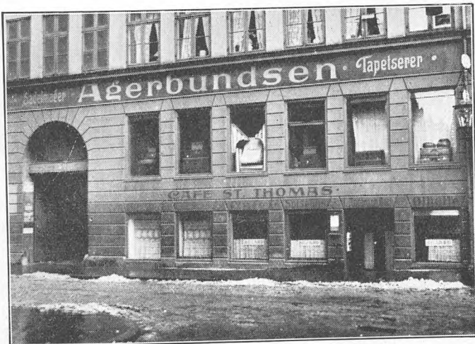
W. Agerbundsens Forretning.
