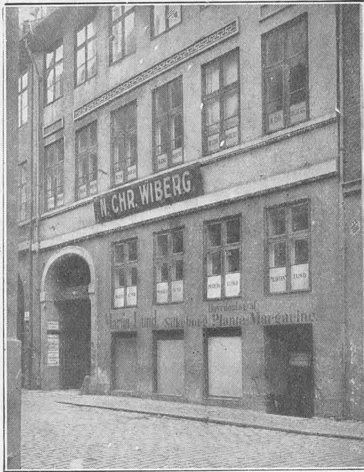
Ejendommen, hvori Firmaet N. Chr. Wiberg har Kontorer.
