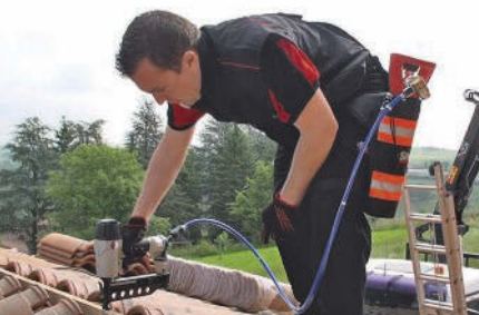
LE COMPRESSEUR PORTATIF, UNE INNOVATION QUI FACILITE LE TRAVAIL DANS LES LIEUX DÉPOURVUS D'ÉLECTRICITÉ.
