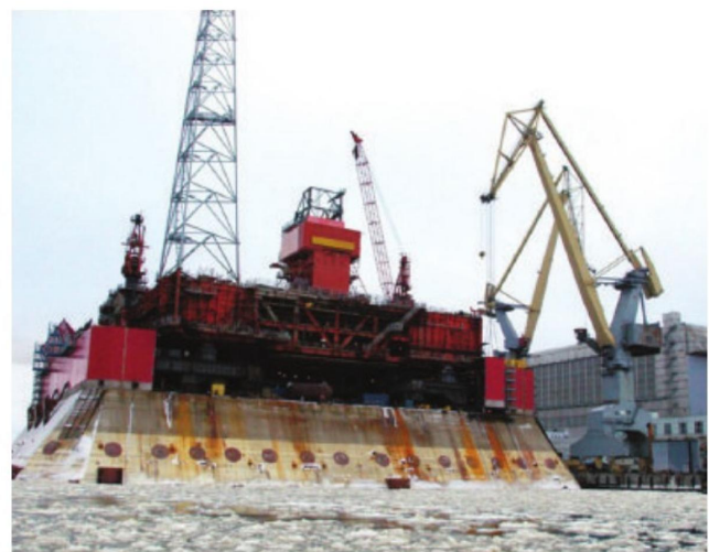
▲ La plate-forme de Prirazlomnaya aura une capacité de 22 000 tonnes de pétrole et 1 million de mètres cubiques de gaz par jour
