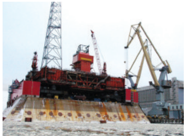
▲ La plataforma Prirazlomnaya tendrá una capacidad de 22.000 toneladas de petróleo y 1 millón de metros cúbicos de gas por día
