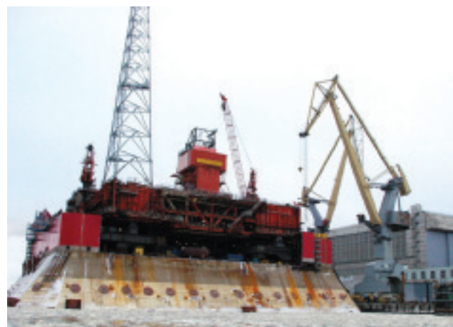
▲ Die Pirazolomnaya-Plattform wird eine tägliche Kapazität von 22.000 Tonnen Öl und 1 Million Kubikmeter Gas haben
