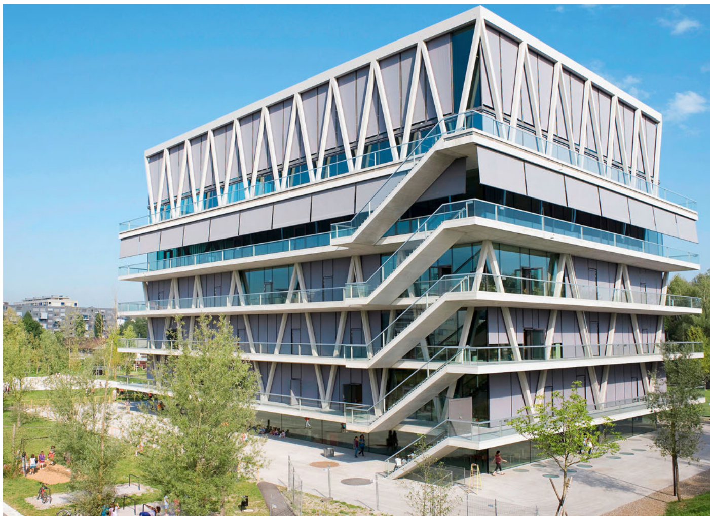
Als zweitgrösstes Schulhaus der Stadt Zürich ist die Anlage Leutschenbach nach dem Entwurf des Zürcher Architekten Christian Kerez erstellt worden.
