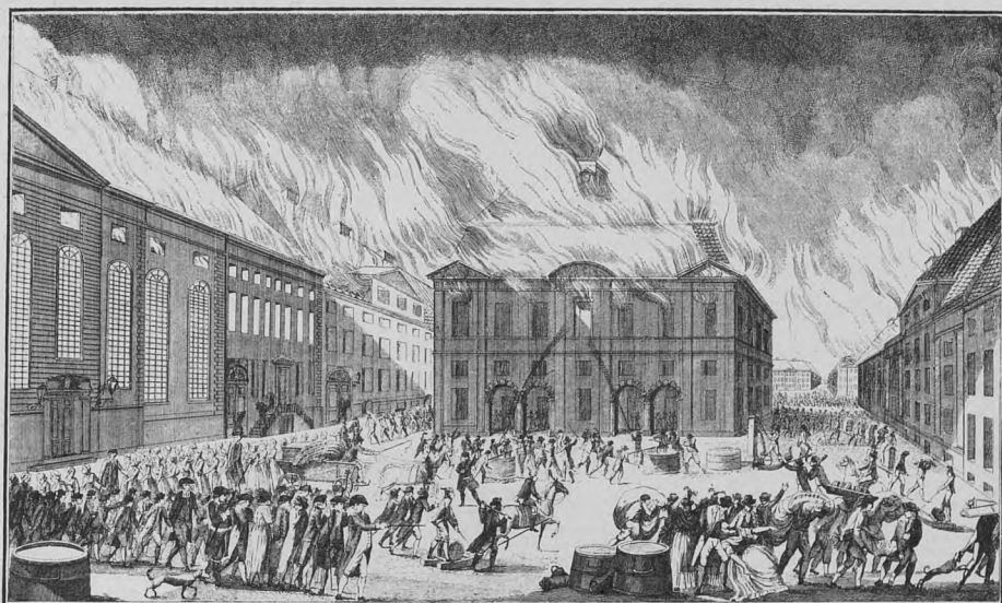
52. Raadhusets og Vajsenhusets Brand, set fra Nytorv. Stik af A. Flint.
