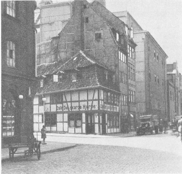
Gothersgade Elektricitetsværk. Kedelhusfacade mod Adelgade 1936.
