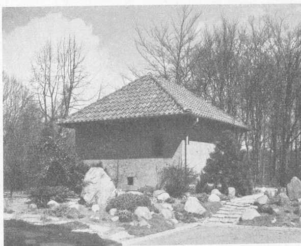
Transformatoranlæg i muret Hus, nyere Udførelse (Rigshospitalet 1933).
