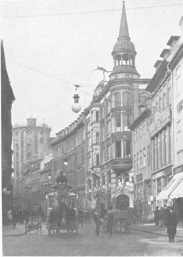
Buelamper i Tværophæng (Købmagergade 1900). Lyspunkthøjde 7,5 m.
