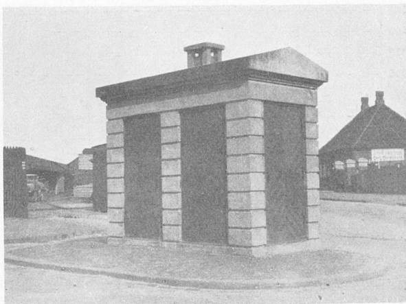
Transformatoranlæg i muret Hus, ældre Udførelse (Vermlandsgade 1918).
