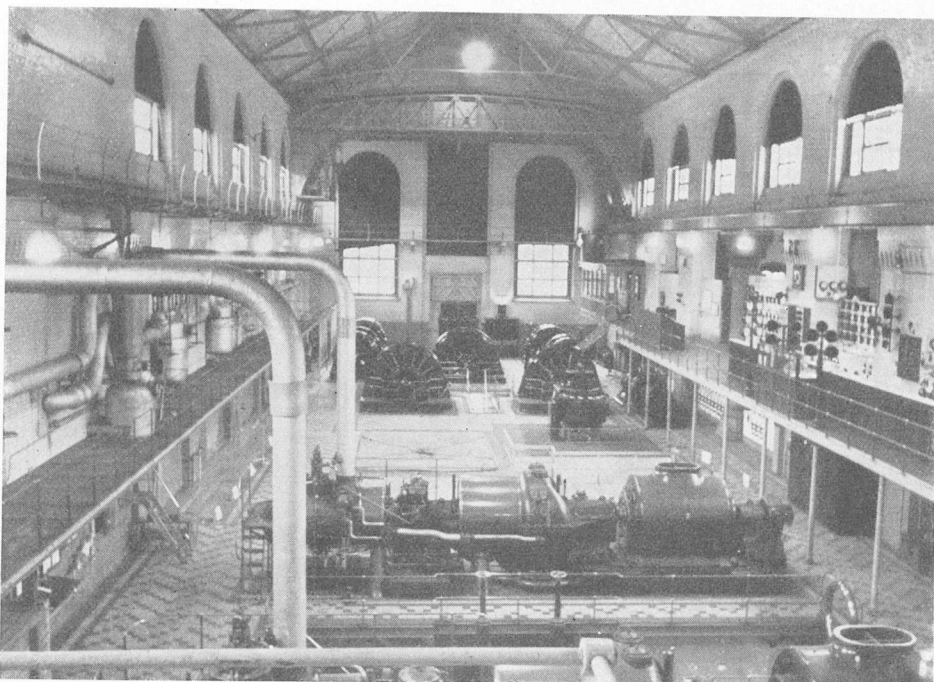
Østre Elektricitetsværk, Maskinsal. I Forgrunden Turbine 2 og lidt af Turbine 1, i Baggrunden Omformere og Ensrettere. For Vinduerne ses Mørklægningsgardinerne.
