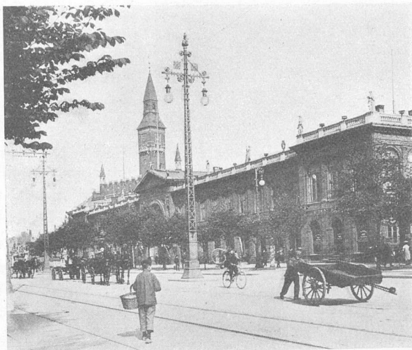
Gittermaster med Buelamper (Vesterbros Passage 1905). Lyspunkthøjde 9,5 m.
