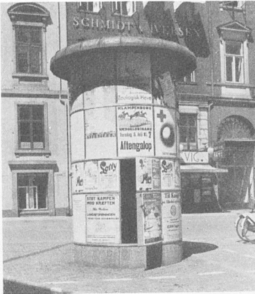
Ventilationstaarn med Nedgang til underjordisk Transformatoranlæg (Gammel Torv 1937).
