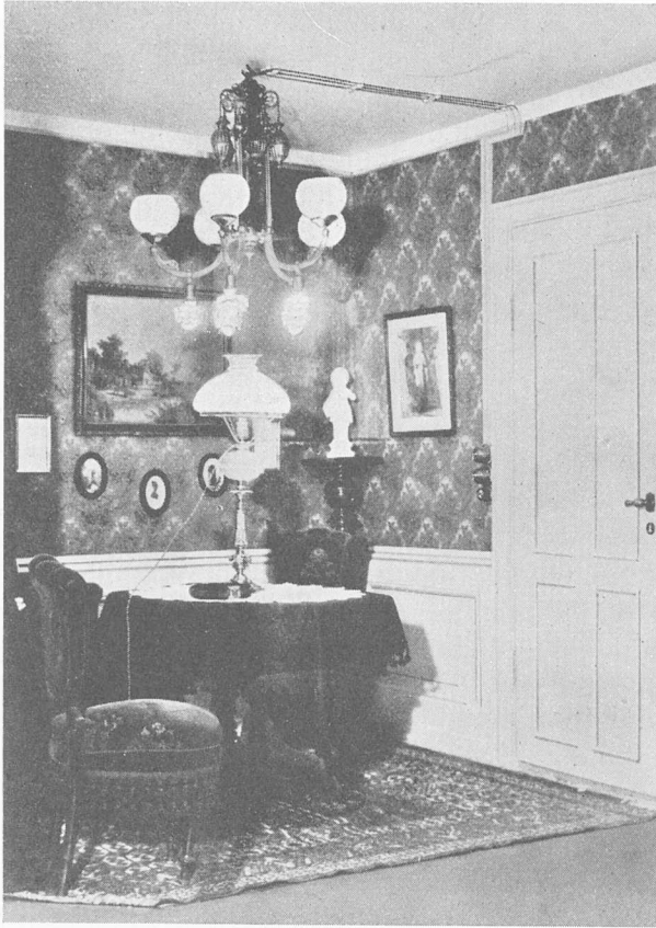
Knapinstallation i Dagligstue til en Gas-Lysekrone, der er udvidet med elektriske Lamper. Hullisteinstallation til Afbryder og Stikkontakt. Paa Bordet en ændret Petroleums-lampe (ca. 1895).
