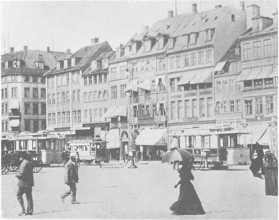
Opladning af Akkumulatorvogne paa Kongens Nytorv. Den ene Ladeopstander ses umiddelbart til højre for Damens Parasol, den anden til venstre for hende omtrent midtvejs mellem Parasollen og den holdende toetages Hestesporvogn.
