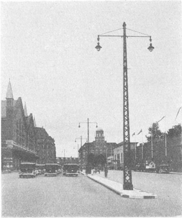
Gittermaster med 1,5 m Lampearme (Bernstorffsgade 1940). Lyspunkthøjde 8,7 m.
