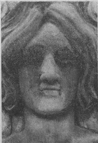
En af sandstens-karyatiderne på Børsens facade før (øverst) og efter restaureringen (nederst)
